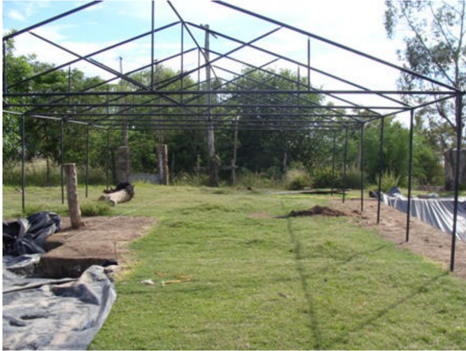
Foto 43: Área delimitada para excavar
