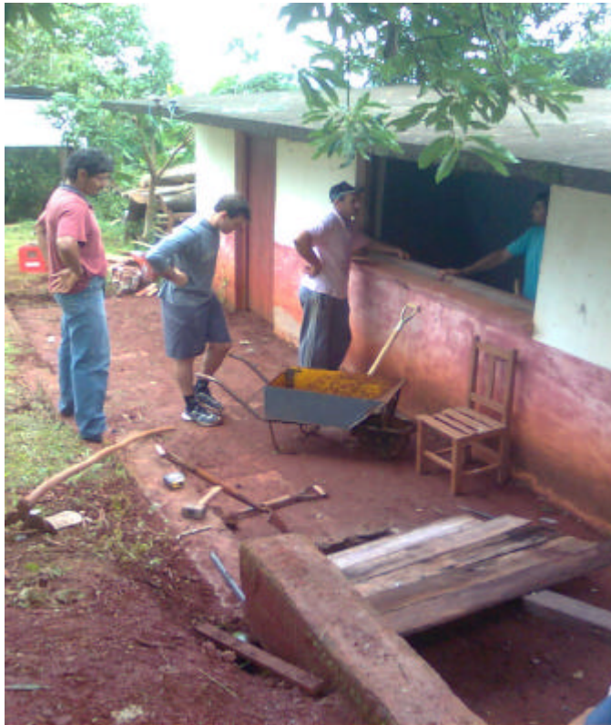
Padres y docentes acondicionando acceso y aula que antes funcionaba como cantina
