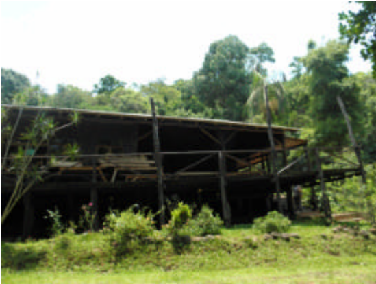
Vista de la casa en Don Rodolfo
