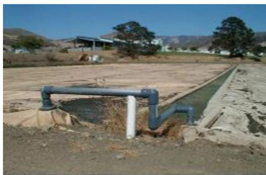
*Laguna anaeróbica con cubierta flotante y sistema de recuperación del biogás generado*
