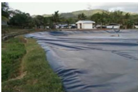
*Laguna anaeróbica con cubierta*
