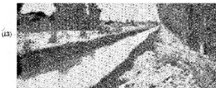
13.  $n = 0.029$ . Canal en tierra excavado en un suelo de limo aluvial, con depósitos de arena en el fondo y crecimiento de pastos.
