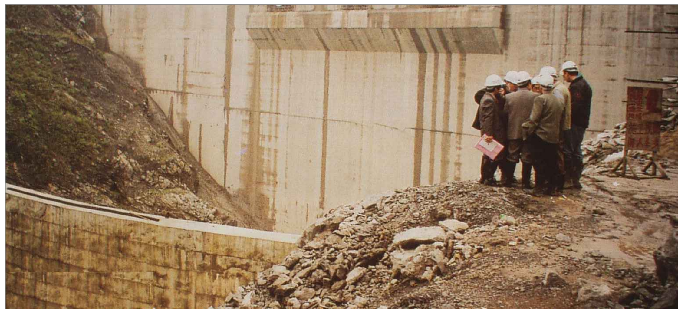
VISTA DE LA TERMINACION DE LA CARA DE AGUAS ARRIBA DE UNA PRESA DE HCR
