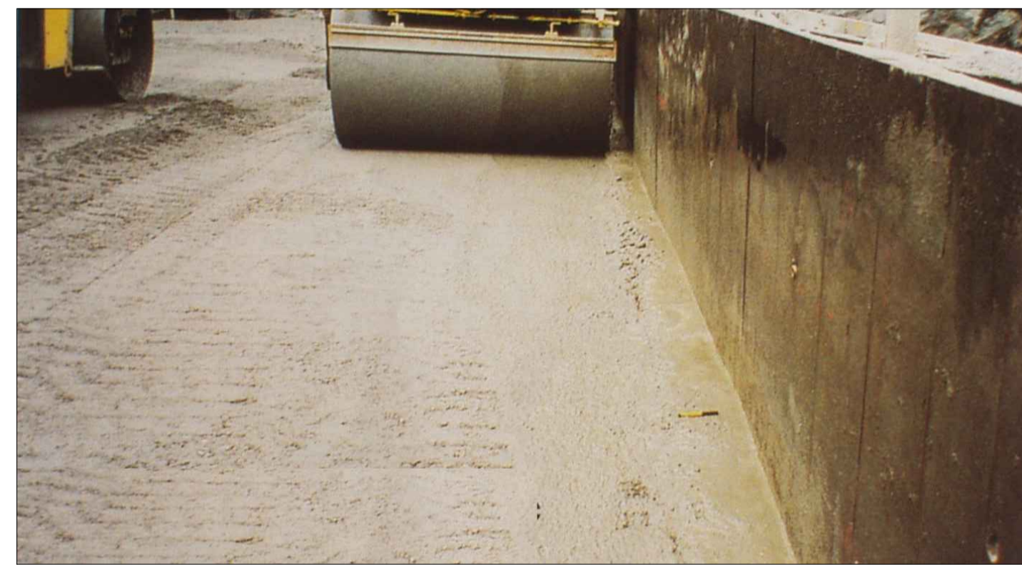
COMPACTACION DEL HCR EN LA CARA DE AGUAS ARRIBA
