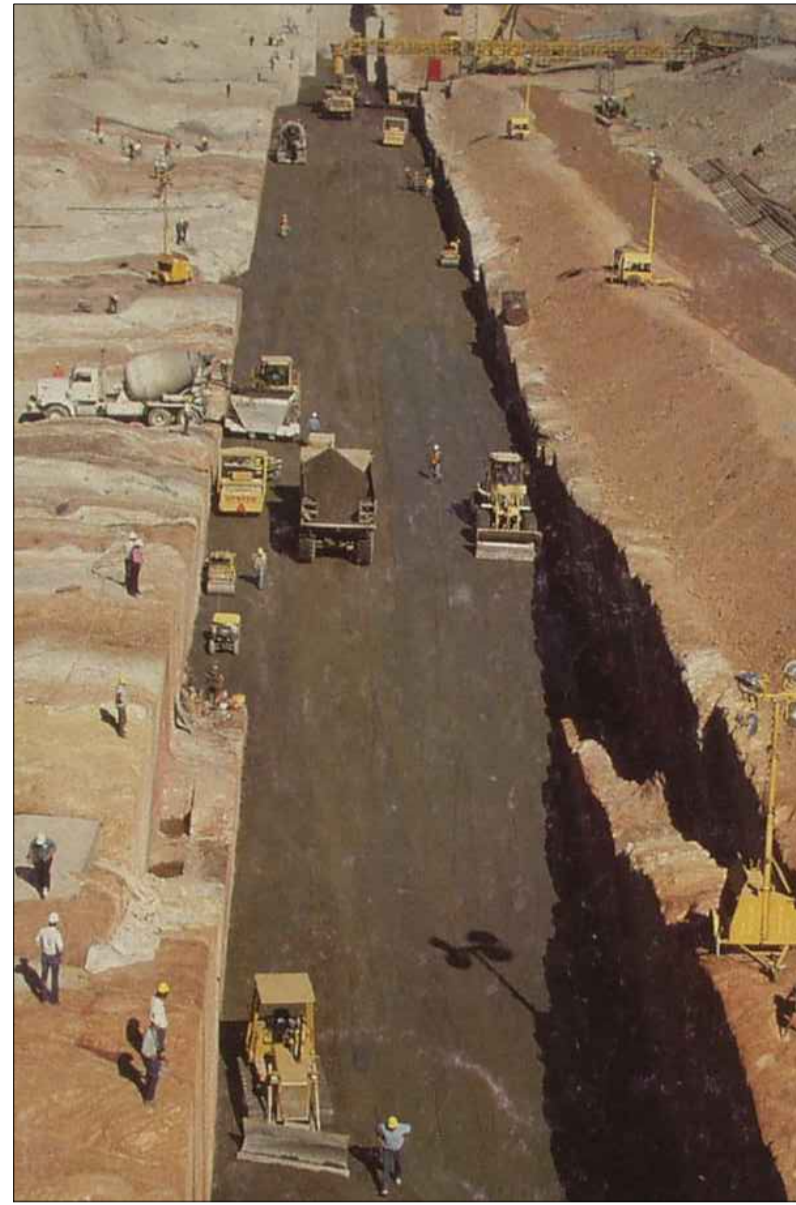
VISTA DE LA CONSTRUCCION DE LA PRESA
