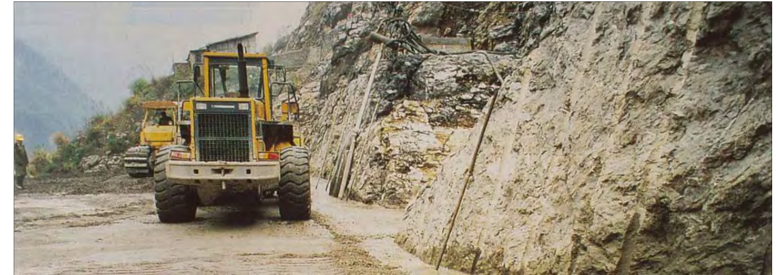
HCREL COMPACTADO CONTRA EL EMPOTRAMIENTO DE ROCA Y EL HCR PREVIO A LA COMPACTACION DEL HCR
