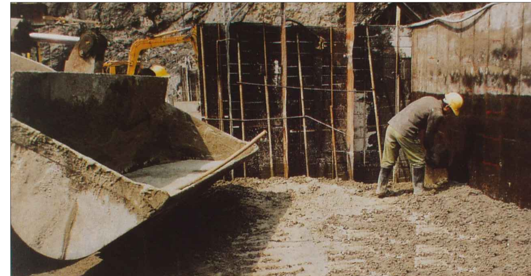
PREPARACION DE LA LECHADA (GROUT) SOBRE LA CARA DE AGUAS ARRIBA DE LA PRESA
