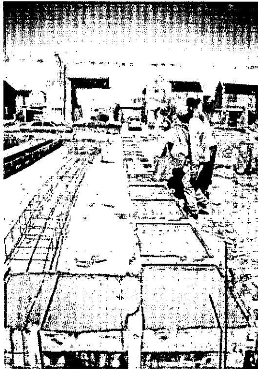
Fig. 9 y 10. Inicio de la construcción del centro agroalimentario de la comarca VIRCH-VALDÉS. La ejecución comenzó con el encadenado periférico e interno de acuerdo con las medidas del plano de obra. Este encadenado o fundación se fabricó con hormigón y barras de hierro estructural armado.
