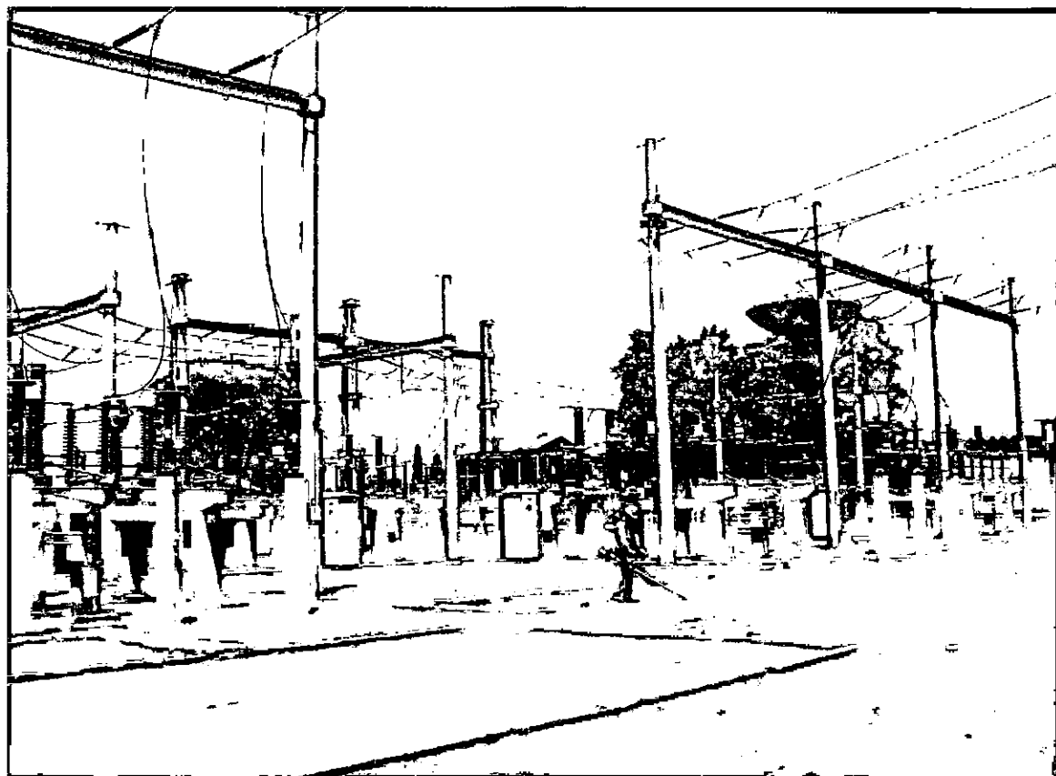
Foto 12 - Pórticos y campos ET Cevil Pozo
