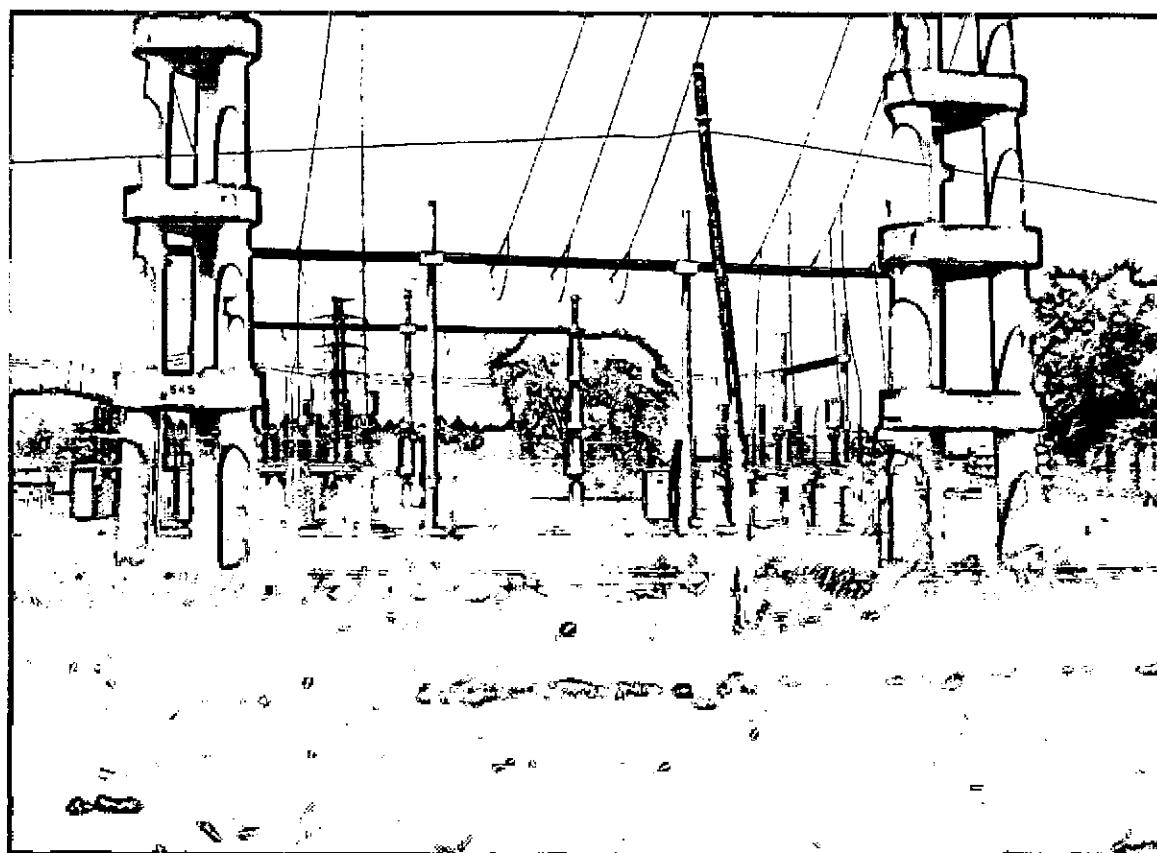
Foto 14 - Predio de la ET desde ruta 302
