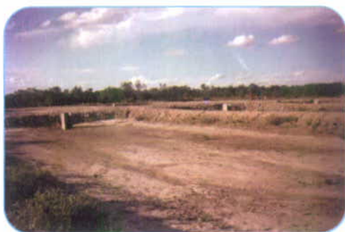
Figura 9: construcción de estanques.
