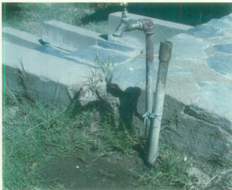
Referencia: una canilla que no cierra bien, y gotea, perdiendo muchos litros de agua por hora en una casa de Belén.
