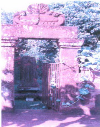
Portal casa privada
