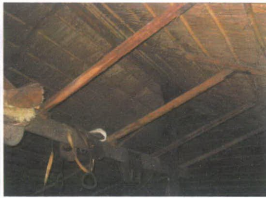
Detalle decorativo y constructivo
