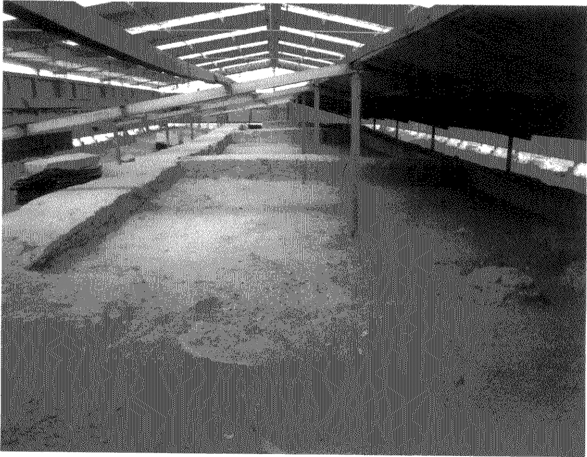
Vista general del Solar Francisco Páez después de las tareas de limpieza
