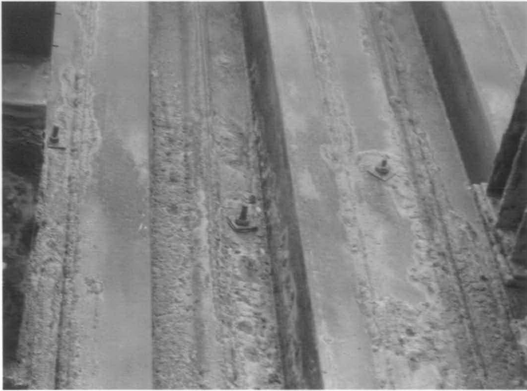
Anclajes transversales en las tablestacas de los dolfinos
