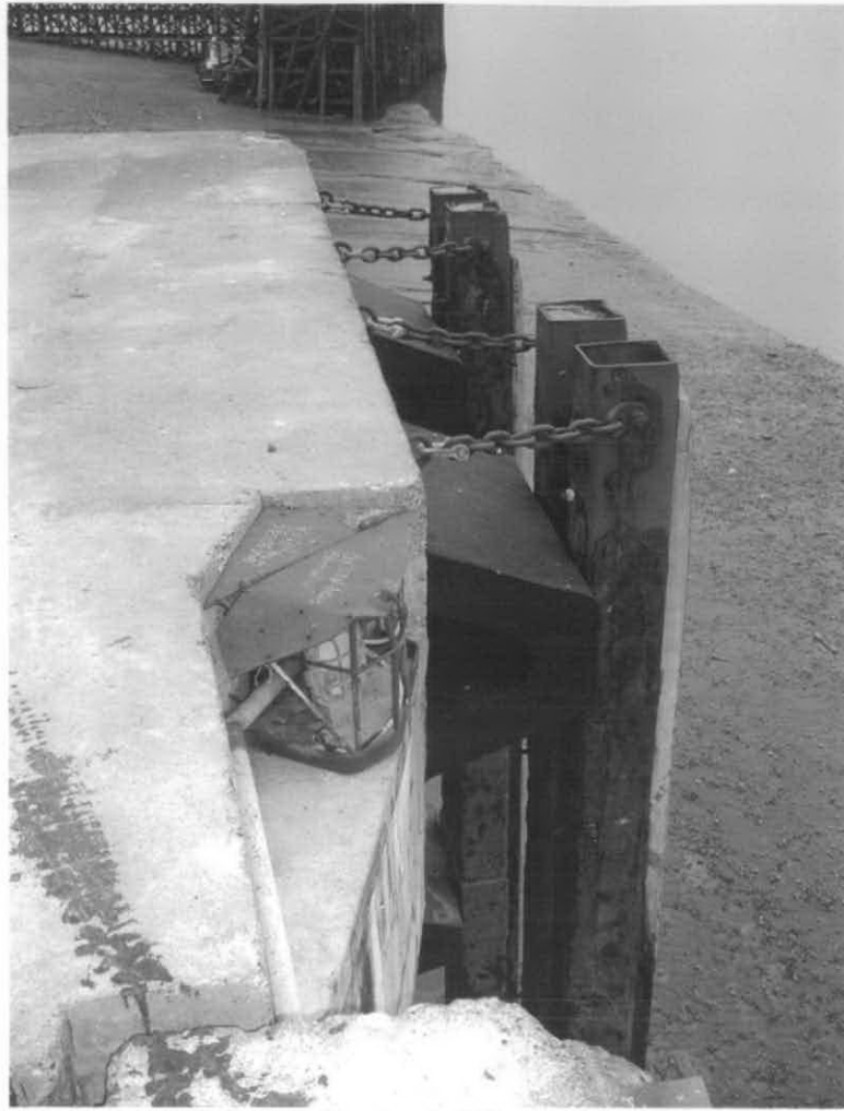
Vista hacia el Oeste del Frente de Atraque
