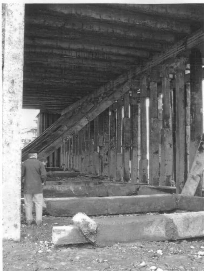
Vista general de las diagonales del muelle
