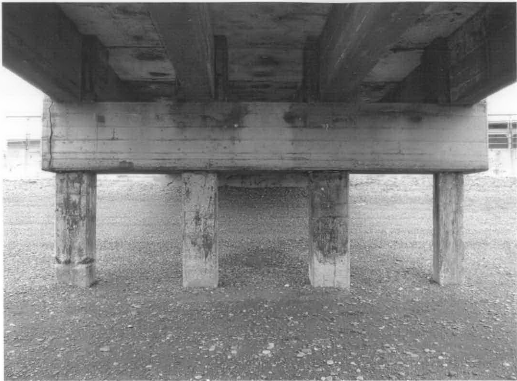
Vista frontal de un cabezal de viaducto
