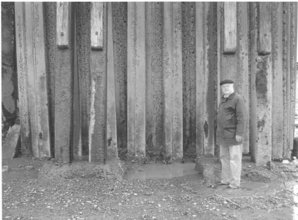
Vista de los dados de hormigón al pie de las defensas en el dolfín oeste
