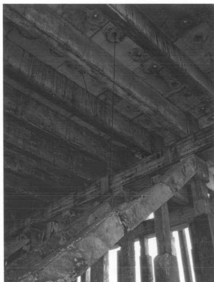
Detalle de una diagonal suspendida de la losa del muelle
