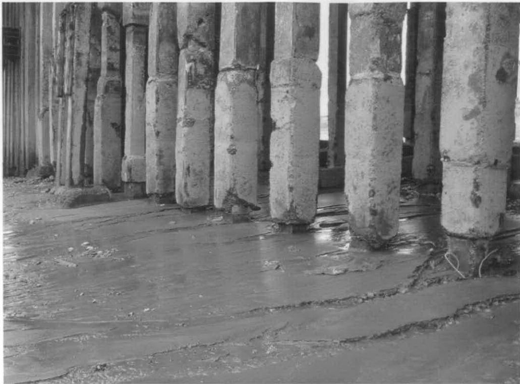
Vista de los pilotes del Frente de Atraque
