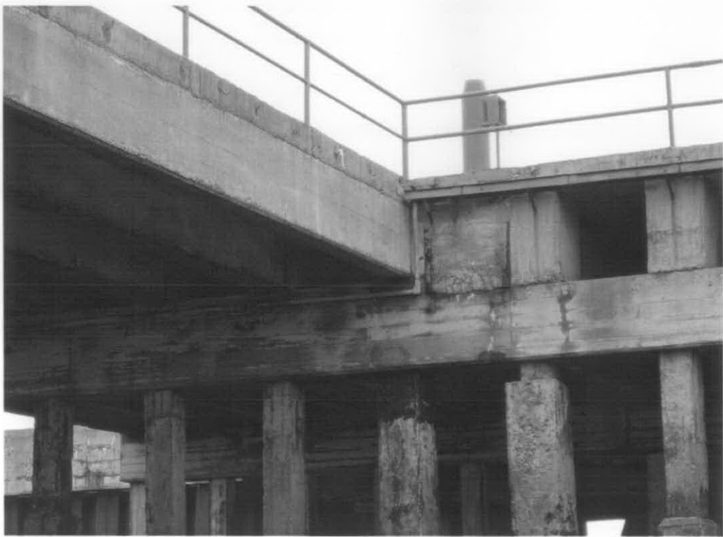
Vista del dado de empotramiento de la columna de iluminación
