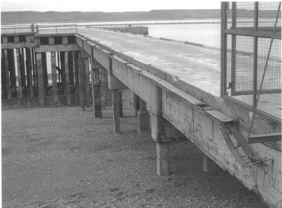
Vista general interior del Viaducto Este
