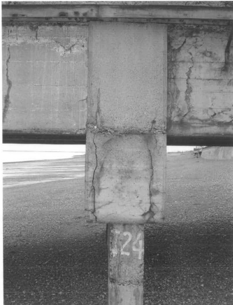
Vista lateral de un cabezal de viaducto
