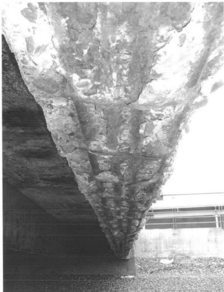
Vista inferior de una viga del viaducto
