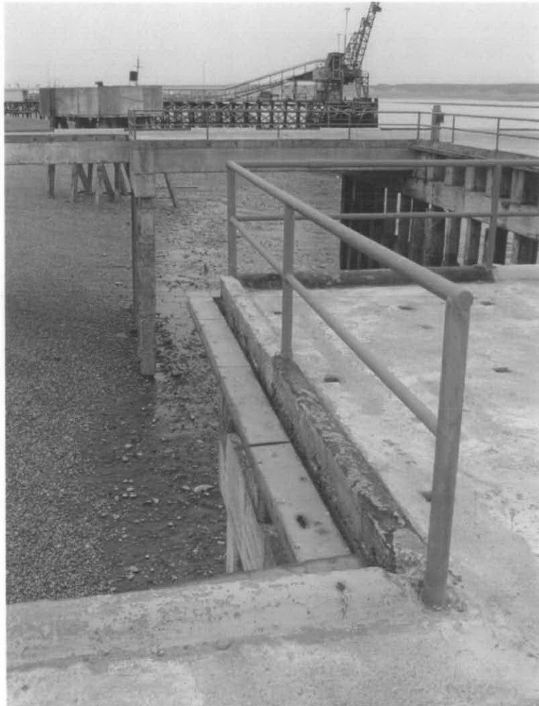
Ensanche en los extremos de los viaductos
