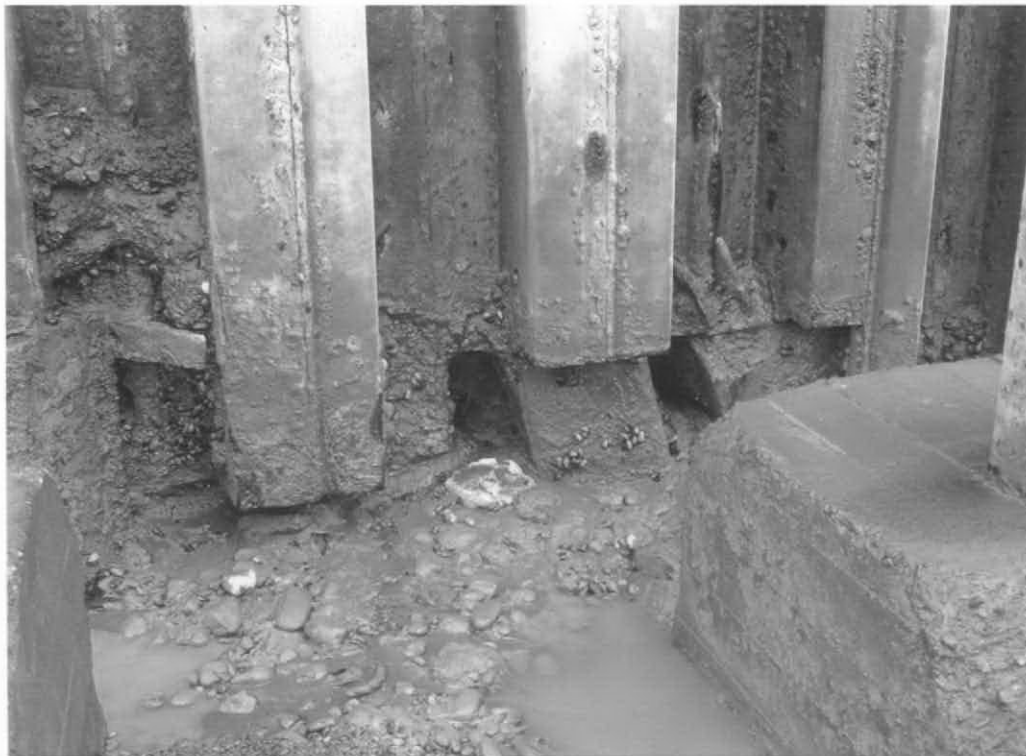
Vista de los recortes de las tablestacas al pie de los dolfinos
