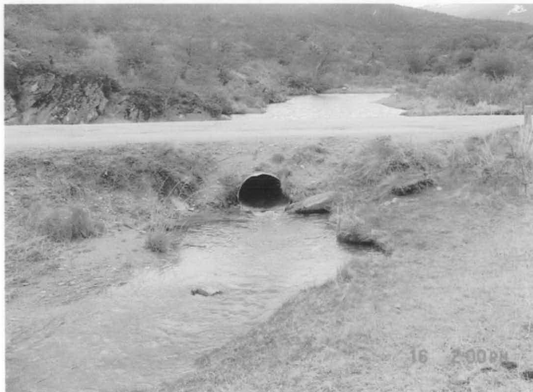
Foto 6.7. Alcantarilla de progresiva 9457.00
