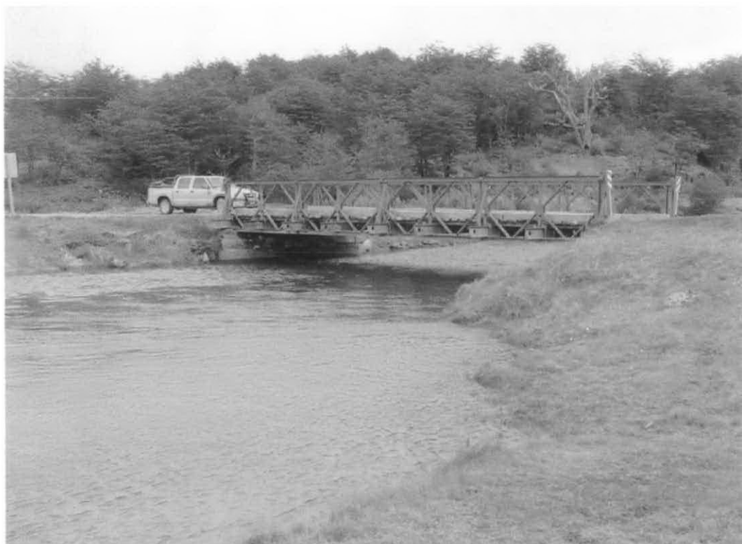
Foto N° 6.8. Puente sobre el Río Ovando
