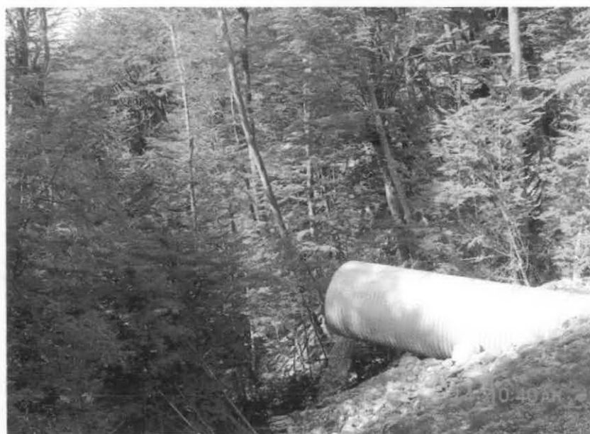
Foto 6.2. Alcantarilla en el A° Pilolo
