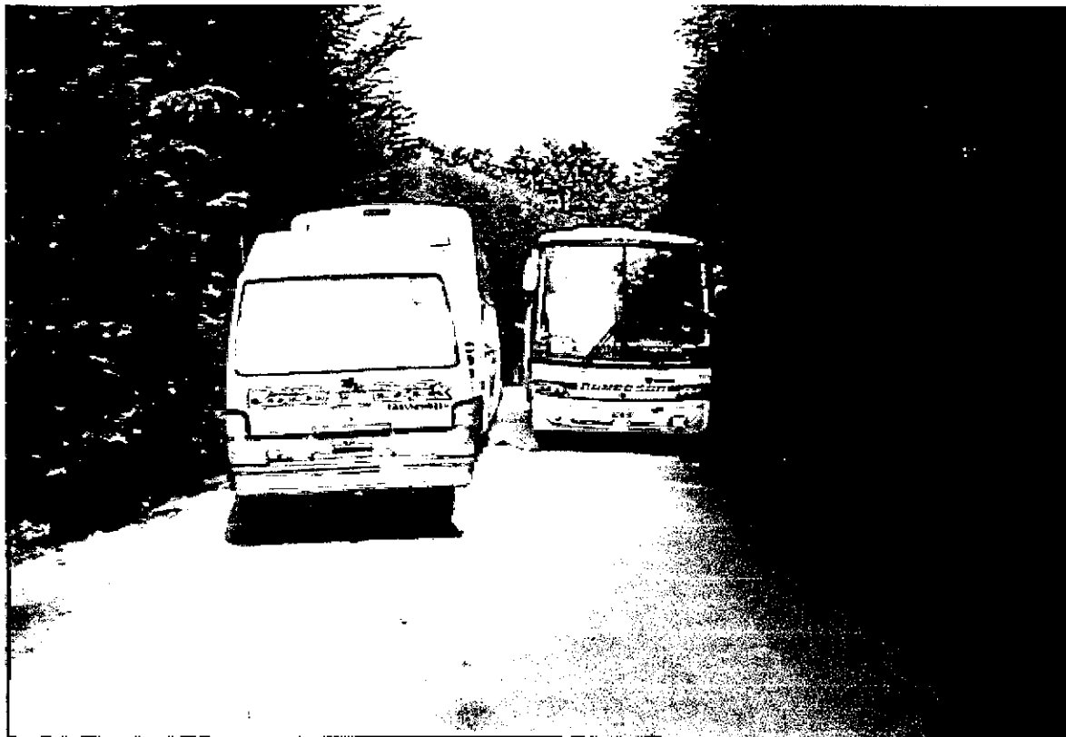
Foto N°4 cruce entre vehículos (el vehículo de la derecha debió retroceder 40m en busca de ancho suficiente para poder cruzar)
