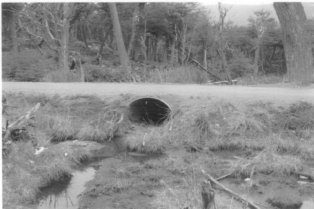
Foto 6.9 Alcantarilla de progresiva 10527.00
