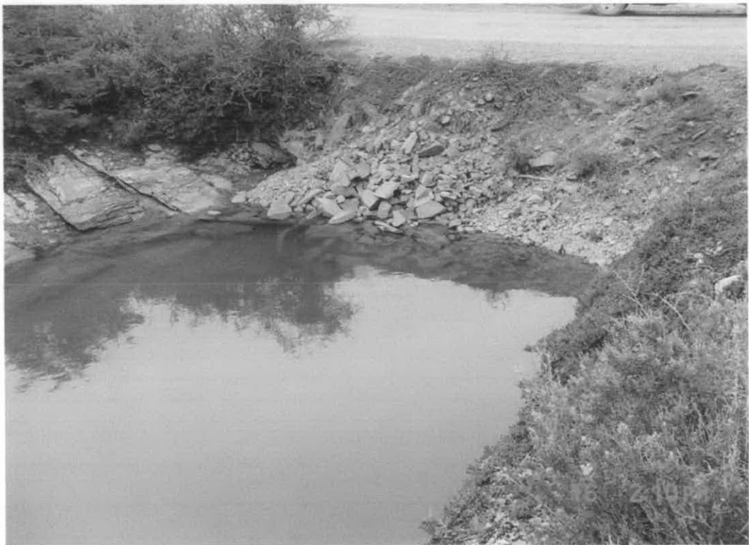
Foto 6.6 Vista aguas arriba en Progresiva 9020.00
