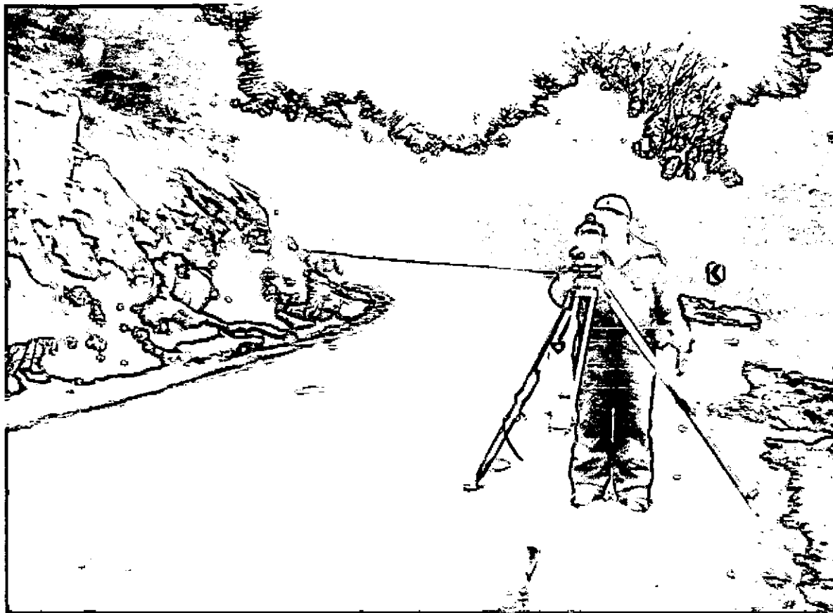
Foto N°6: jefe de topografía de la DPV con estación total en tareas de relevamiento según metodología denominada a “estación libre”.
