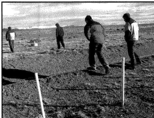
Predio donde se ubicarán las cortinas
