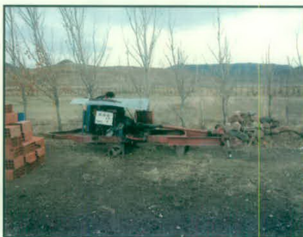
Motor a gas-oil sobre un chasis utilizado como fuerza motriz para bomba centrífuga
