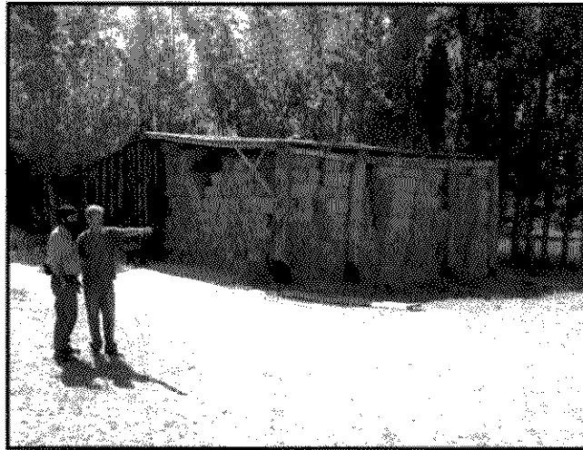
Utilización de postes de álamo para galpones
