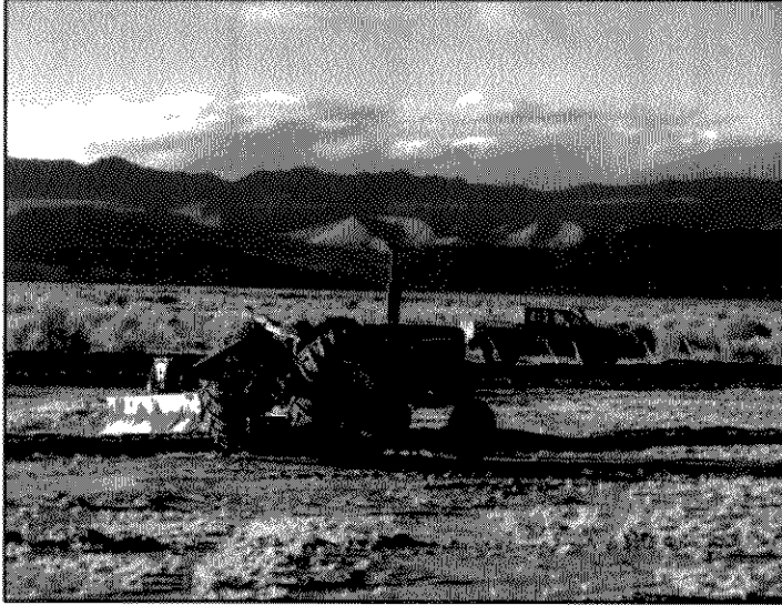
Maquinaria utilizada para la construcción de canales
