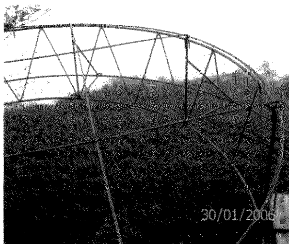
Fotos 15 y 16: Estructura principal de las jaulas Mc10.
