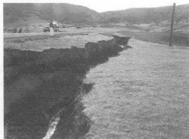
Área de futura urbanización. Debido a la alteración de los sistemas de drenaje se han formado cárcavas muy activas de hasta 2.5 m de profundidad que amenazan la infraestructura vial.
