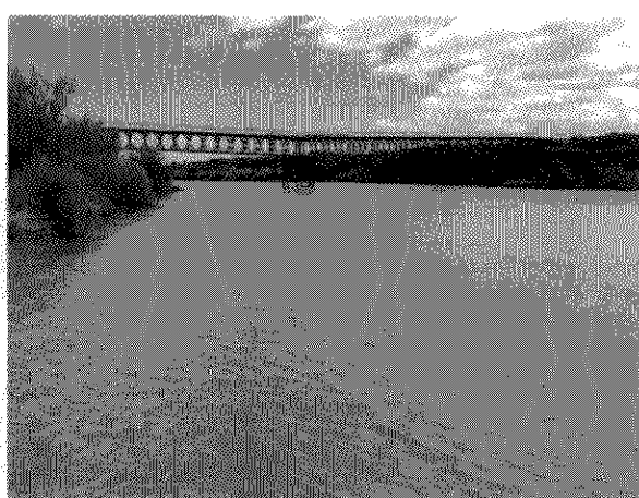
Puente de Desfiladero Bayo.
