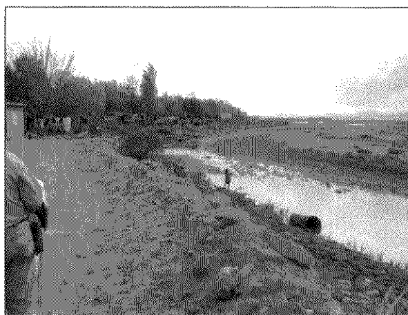
Zona Afectada por las inundaciones del 2002
