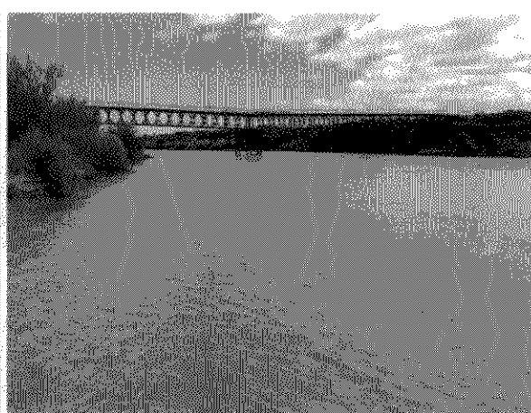
Puente de Desfiladero Bayo.
