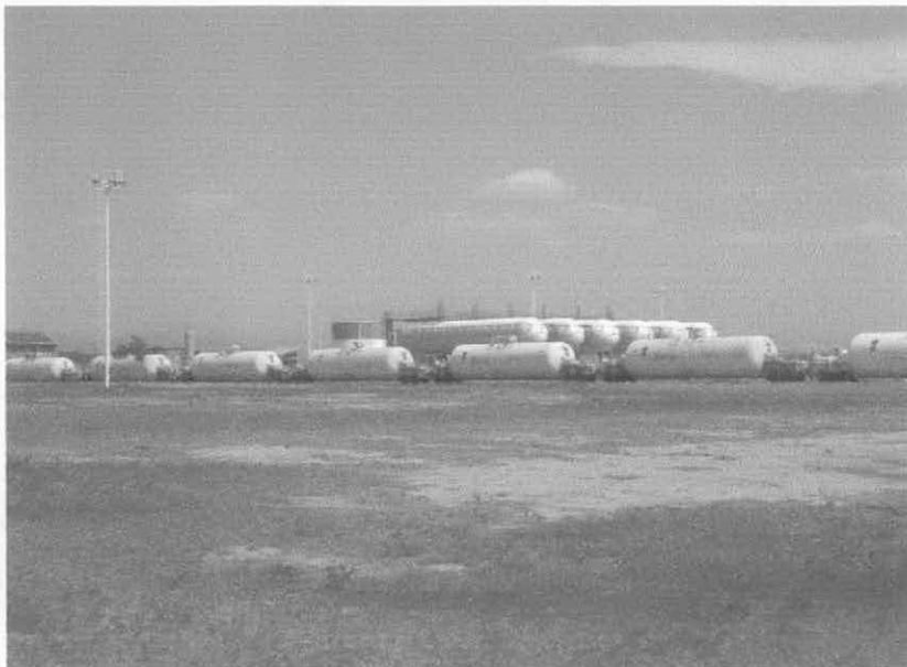
Foto 11. Planta de Despacho de GLP de REFINOR S.A.
