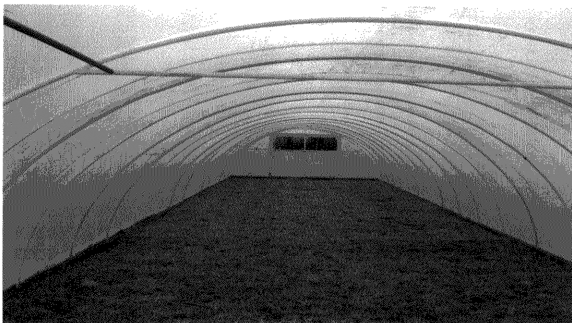
Foto N° 9: Vista del interior de anterior invernadero, nótese que los arcos están hechos con tuberías de gas de ¾"
