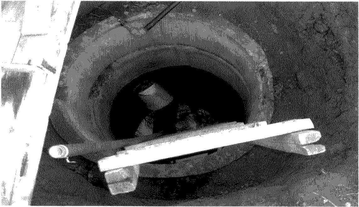
Foto N° 25: Pozo balde para suministro de agua para riego en invernadero. Gobernador Gregores
