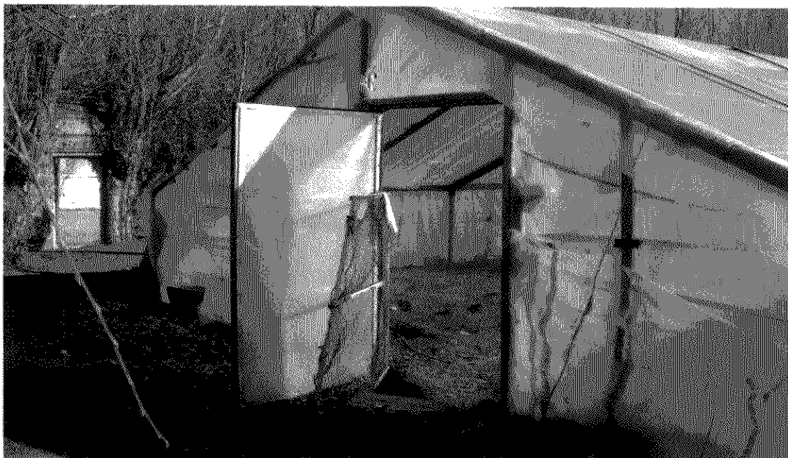
Foto N° 1: Invernadero tipo capilla cubierta de polietileno en la localidad de Perito Moreno
