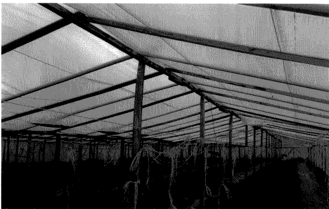
Foto N° 4: Detalle interior de invernadero tipo capilla de 1000 m2. de madera. Los Antiguos.
