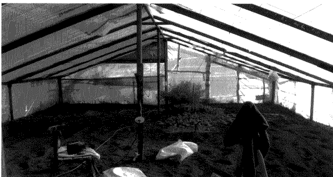
Foto N° 2: Vista del interior donde se observa la estructura de caños, reforzada para prevenir los fuertes vientos presentes en la zona
