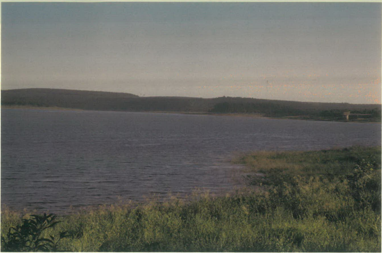
▲ El agua que provee la selva produce la energía de la presa Urugua-í.
