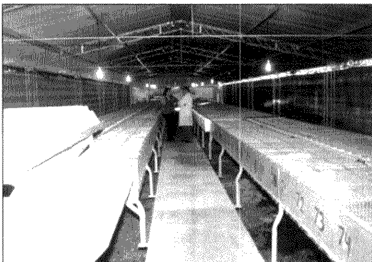
Detalle disposición de jaulas y fosas recolectoras
