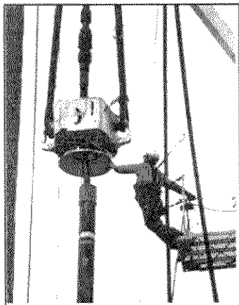
Bajando cañería de revestimiento (Casing)
