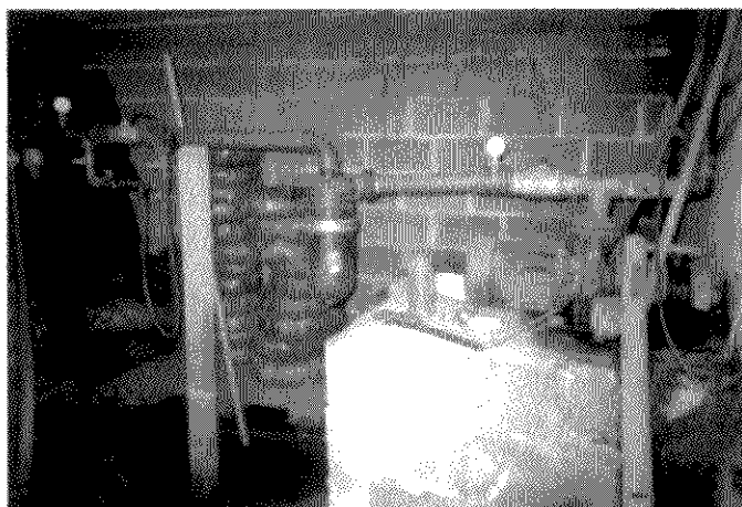
Sala de riego. Cabezal de riego con inyección de fertilizante por Ventura y filtros. Atrás se observan las coronas que realiza con las rosas de menor calidad.
