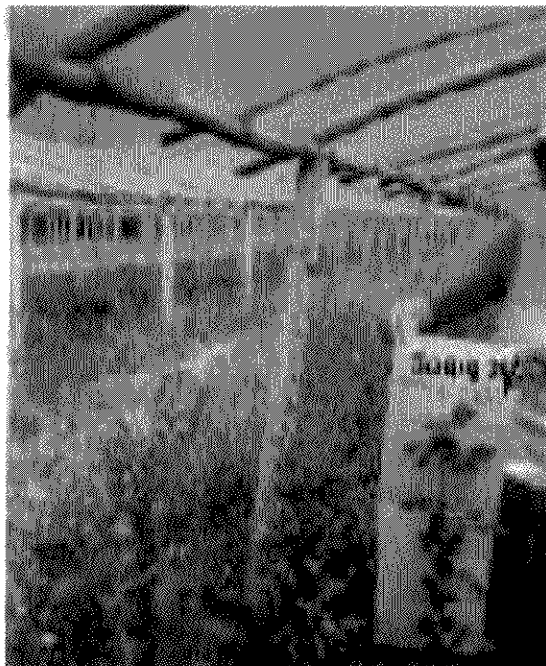
Figura 3. Los invernaderos construidos tienen dimensiones no adecuadas, la altura de laterales y cumbre es baja y, en el caso de la foto, tienen poca estabilidad frente a los vientos.
