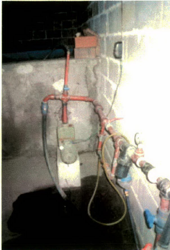
Figura 7. Cabezal de riego con Venturi y piletón de agua para riego (al fondo de la foto). Productor: Sr. Soria.
