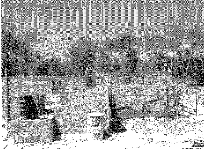
Vivienda llegando a nivel de dintel (derecha).
