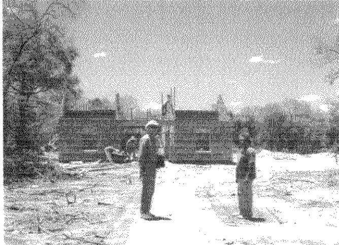
Viviendas a punto de techar
