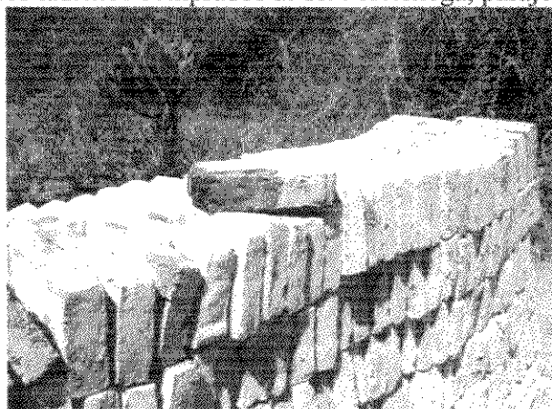
Fuente: Equipo de Vivienda
