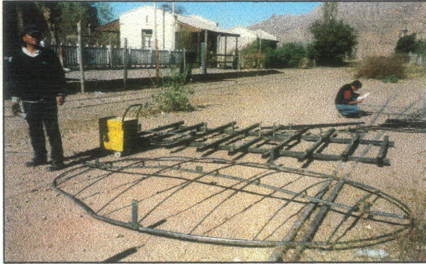
Construcción del reflector solar de foco fijo
