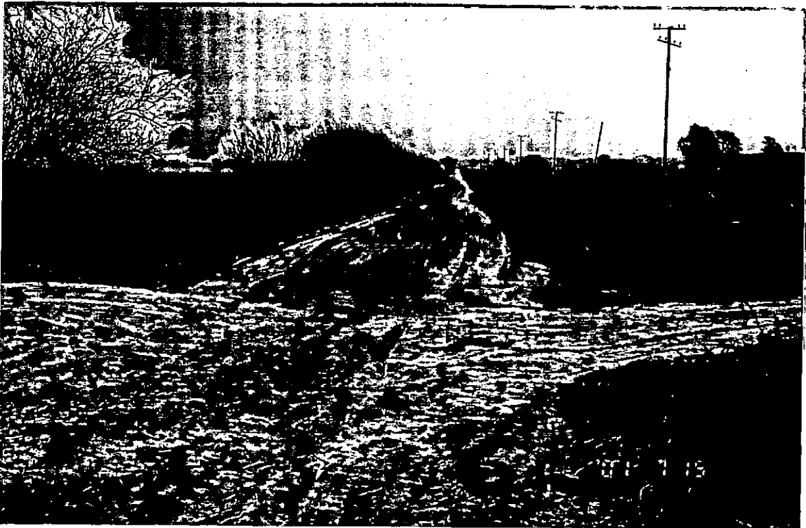
Foto N° 4. Camino sur paralelo a las vías FFCC. Vista hacia el Oeste desde cruce con camino vecinal situado al Este de Tortugas.
