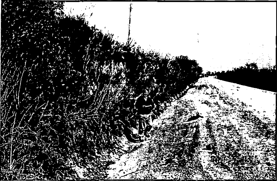
Foto N° 1 Camino rural altamente erosionado, 500 metros al Norte de alcantarilla de cruce donde se inicia el canal interceptor N° 2.
