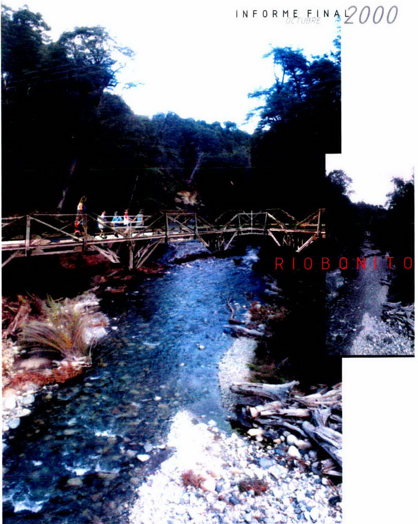
RIO BONITO, PUENTE DEL CIRCUITO PAISAJISTICO
