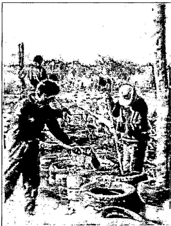
A medida que se colocan los neumáticos, se van llenando con arcilla y se compactan convenientemente.
