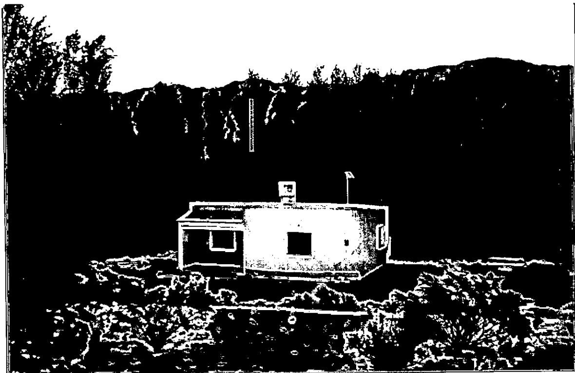
FOTO N° 7: Establecimiento Sanitario Periférico de Enfermería.
