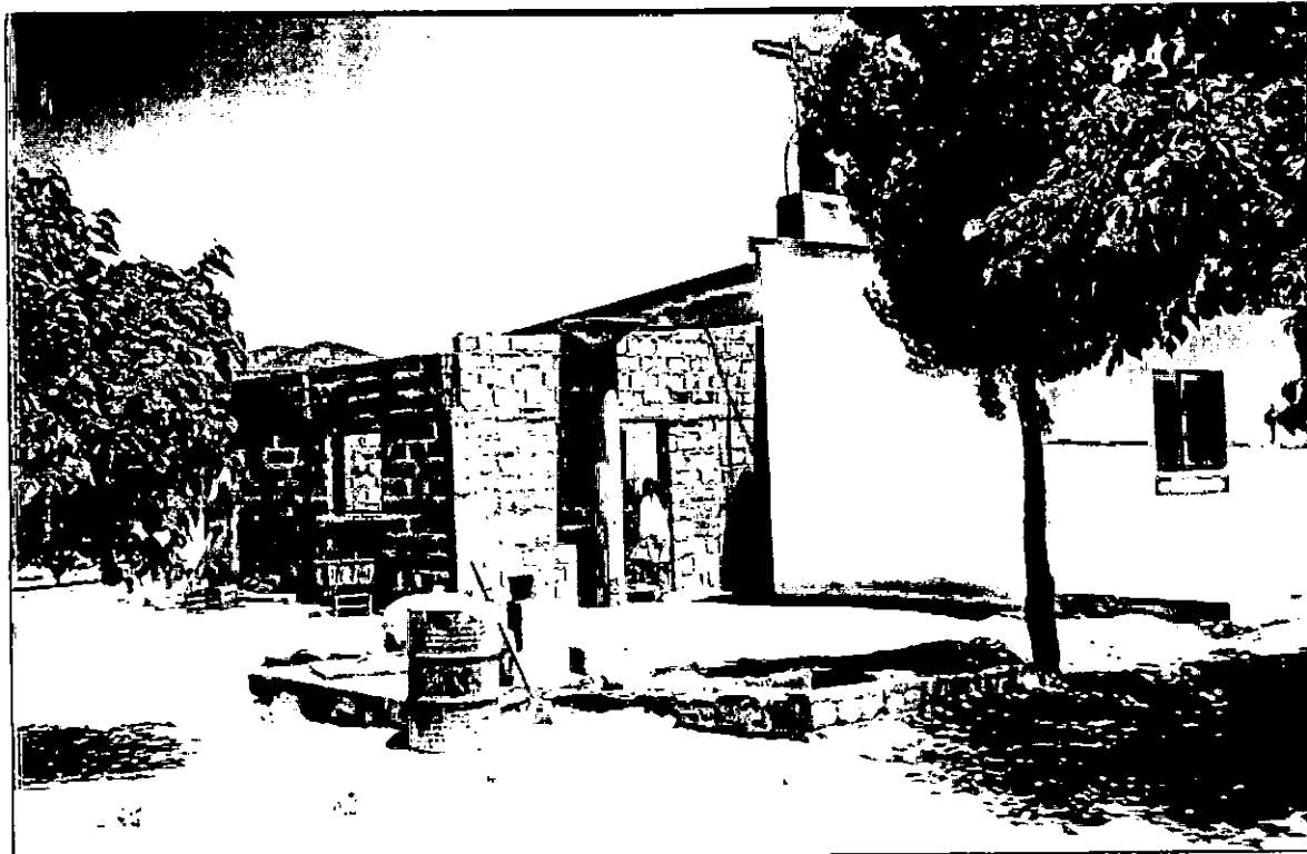
FOTO N° 3: Escuela N° 56. Cocina en construcción.
