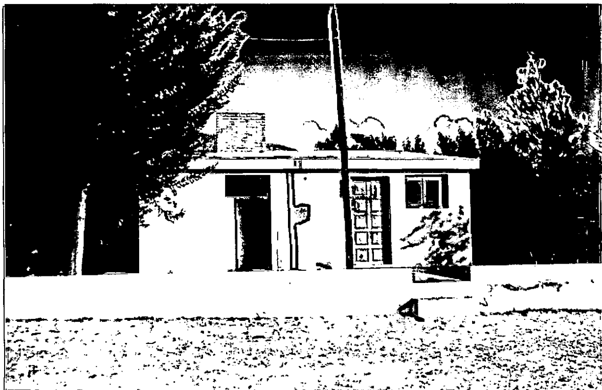
FOTO N° 8: Establecimiento Sanitario Periférico de Enfermería.
