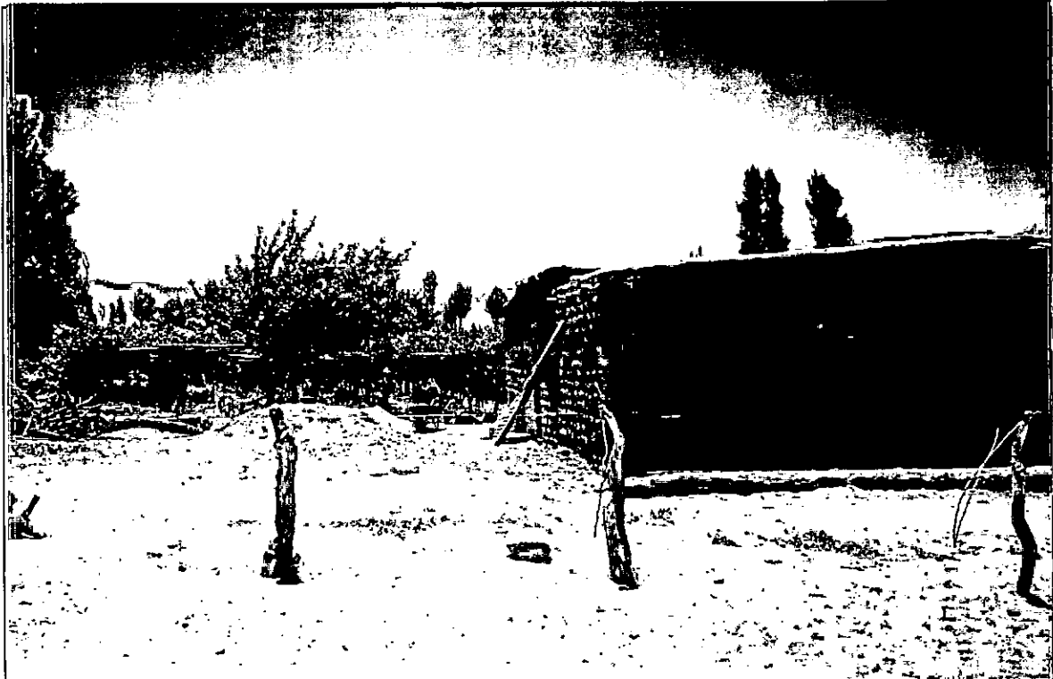
FOTO N° 9: Vivienda típica de la localidad con paredes y techos de adobe. Viñedo.
