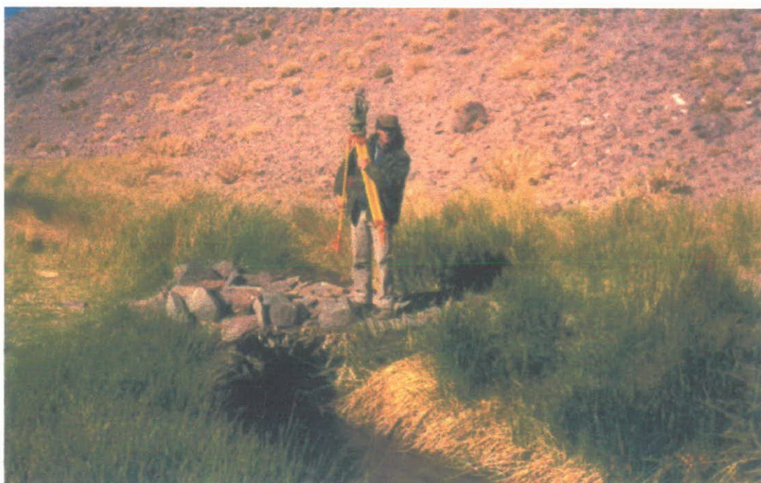
Dos tipos de pasarelas caceras en las vegas grandes de unos 2 m de ancho por 0.90 de altura, la primera se puede retirar en caso de repunte del río y en la misma foto se pueden apreciar las colinas de margen izquierda que delimitan el curso del Río Punilla. En la segunda las de margen derecho.-
