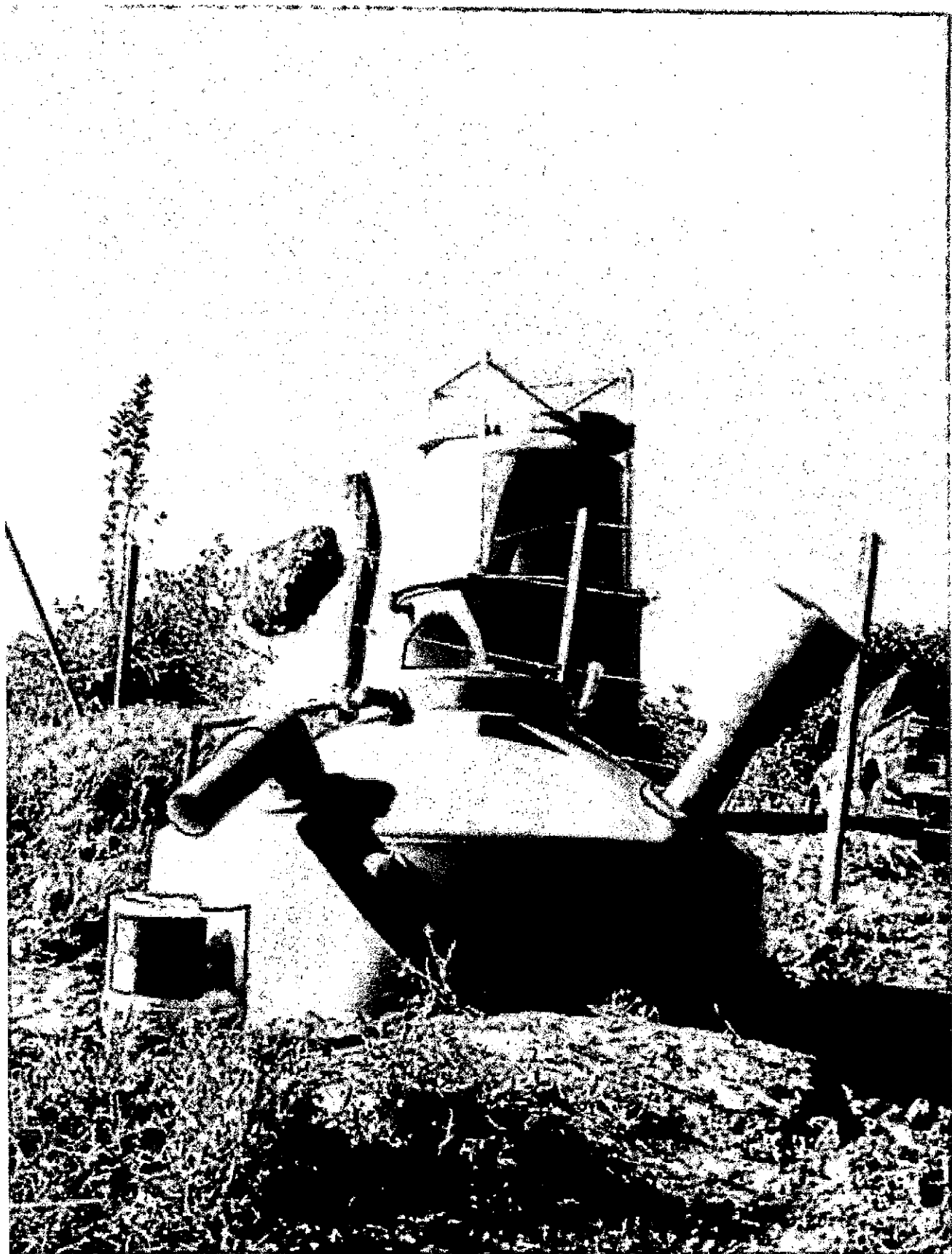
Detalle del Biodigestor y Gasómetro Instalado
