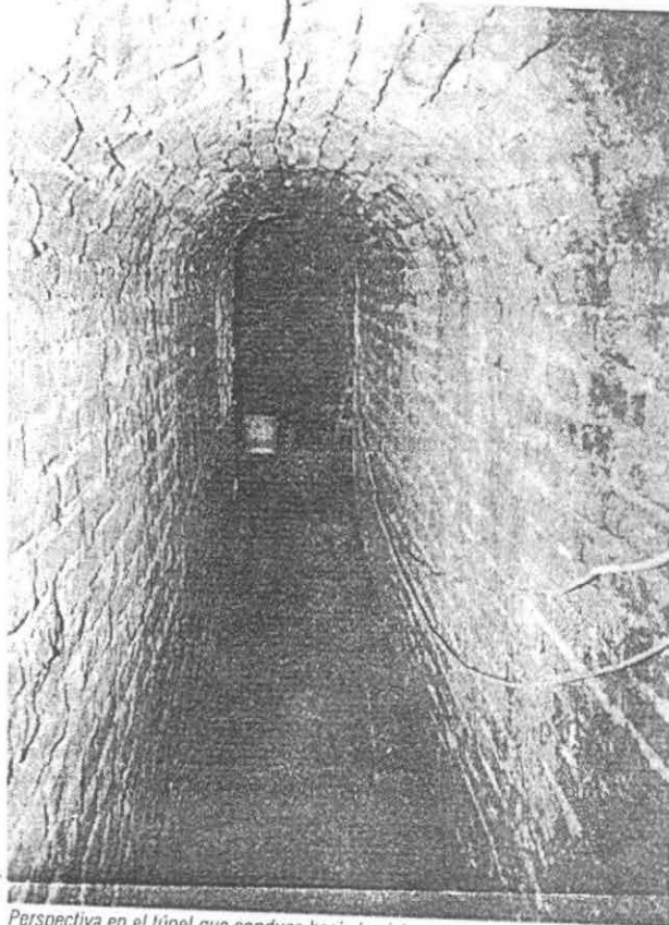
Perspectiva en el túnel que conduce hacia la cisterna.
