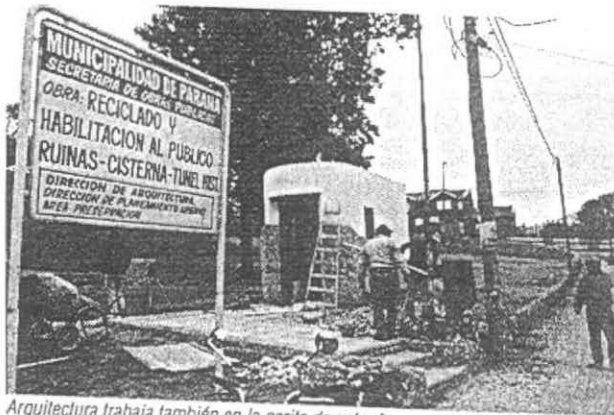
Arquitectura trabaja también en la garita de entrada.
