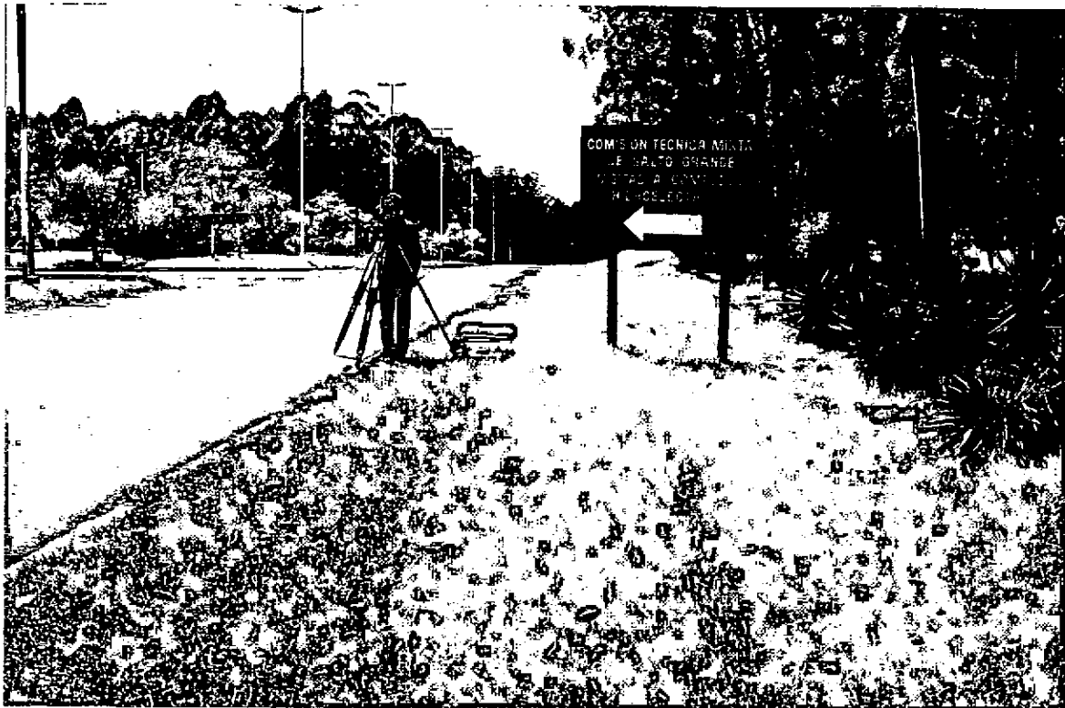
Sector frente edificio Relaciones Públicas CTM de Salto Grande
