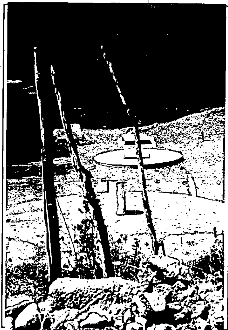
12) Vista en detalle de un sistema individual, consistente en cámara de inspección, cámara séptica y pozo ciego.
