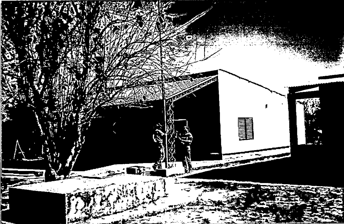
Foto N° 1: Escuela N° 135. Se observa también la cisterna.
