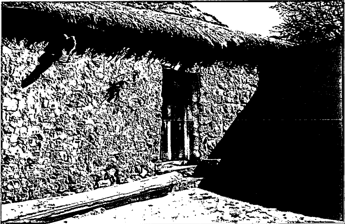
Foto N° 2. Detalle de una vivienda construida con materiales del lugar.
