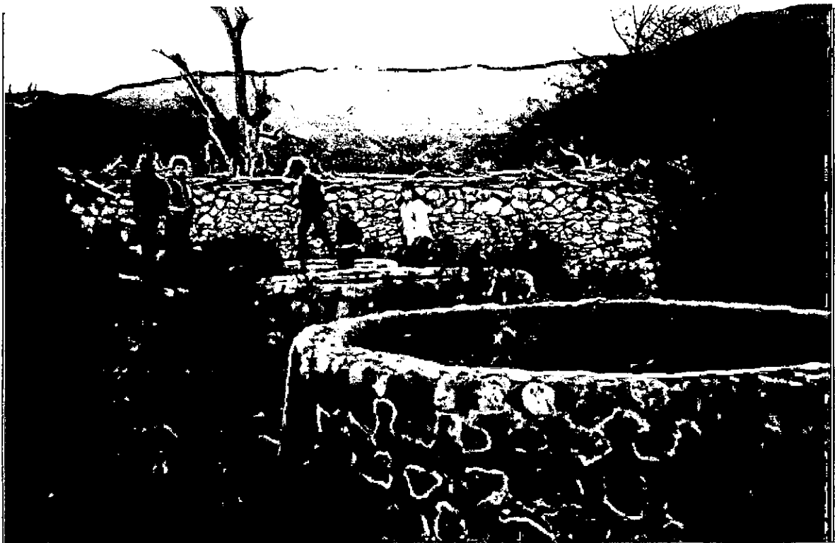
Foto N° 4: Se observa la planta de tratamiento de agua (dos filtros y cisterna).
