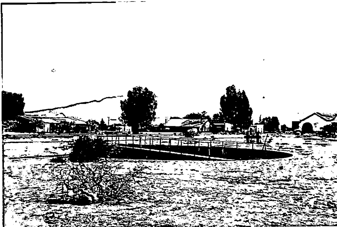
FOTO N° 8: Plataforma giratoria para cambios de material rodante, ubicada en la zona de vías frente al galpón ocupado como Salón Comunitario.
