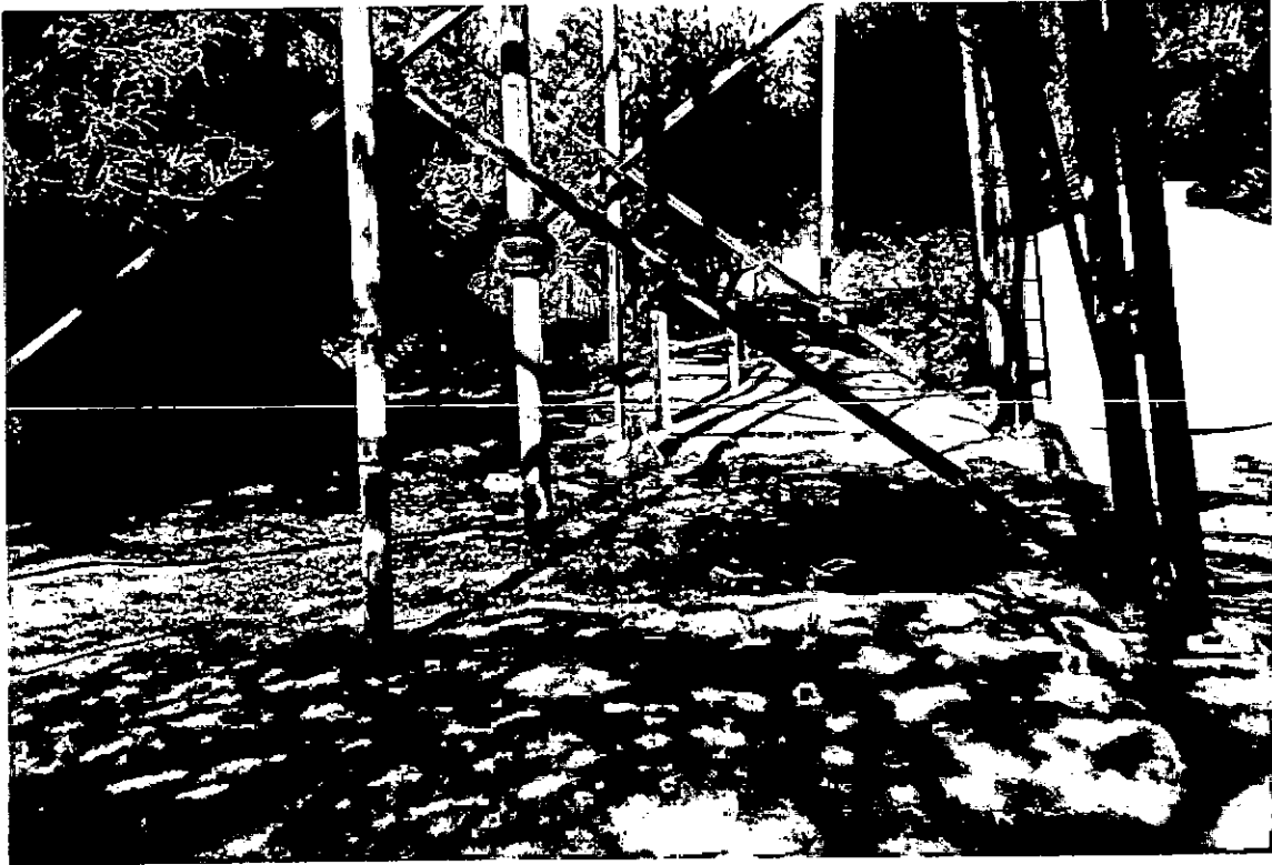
FOTO N° 20: En esta fotografía puede verse la gran cantidad de agua que pierde el tanque, que se estima en unos 3.000 l/día.
