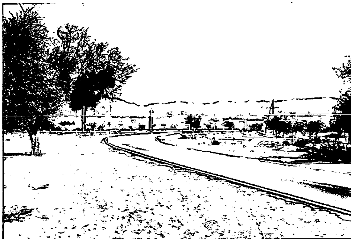
FOTO N° 1: Ruta Nacional N° 60 que permite el acceso a la localidad Estación Mazán. Está pavimentada y se encuentra en buen estado. Esta ruta comunica la localidad con Villa Mazán (7 km.) y con Aimogasta, ciudad cabecera del Departamento Arauco (38 km.).
