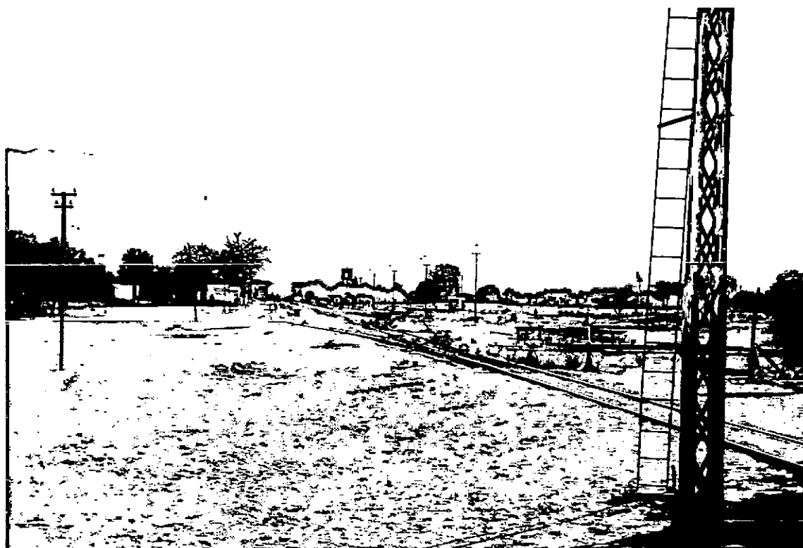
FOTO N°5: Vista general de los terrenos pertenecientes al ferrocarril. En este predio se distribuyen no sólo viviendas que hoy son ocupadas por particulares, sino también construcciones e instalaciones típicas de estaciones ferroviarias entre las cuales sobresale la playa de maniobras.
