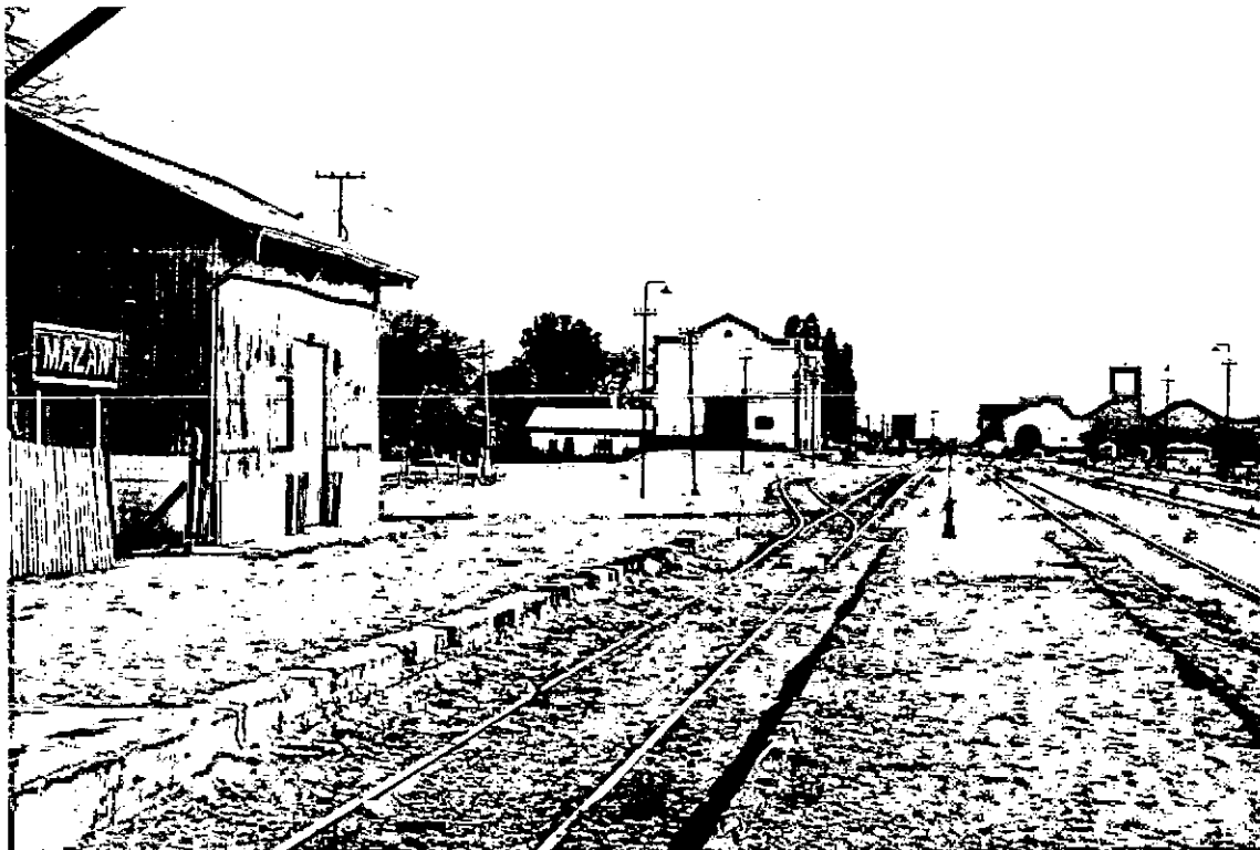
FOTO N° 7: Vista de la playa de maniobras de la estación ferroviaria y a la izquierda del galpón para acopio de materiales y mercaderías que hoy se utiliza como Salón Comunitario. Al fondo pueden verse los galpones de los talleres de material rodante que hoy son ocupados por una empresa que fabrica envases para aceitunas.
