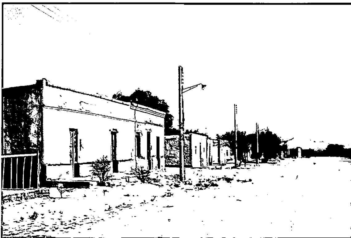
FOTO N° 4: Vista de la calle 9 de Julio, de unos 23 metros de ancho. Pueden verse las características del asentamiento, de tipo rural agrupado con un trazado netamente urbano, al igual que en la foto N° 3, y el tendido eléctrico y de alumbrado público.
