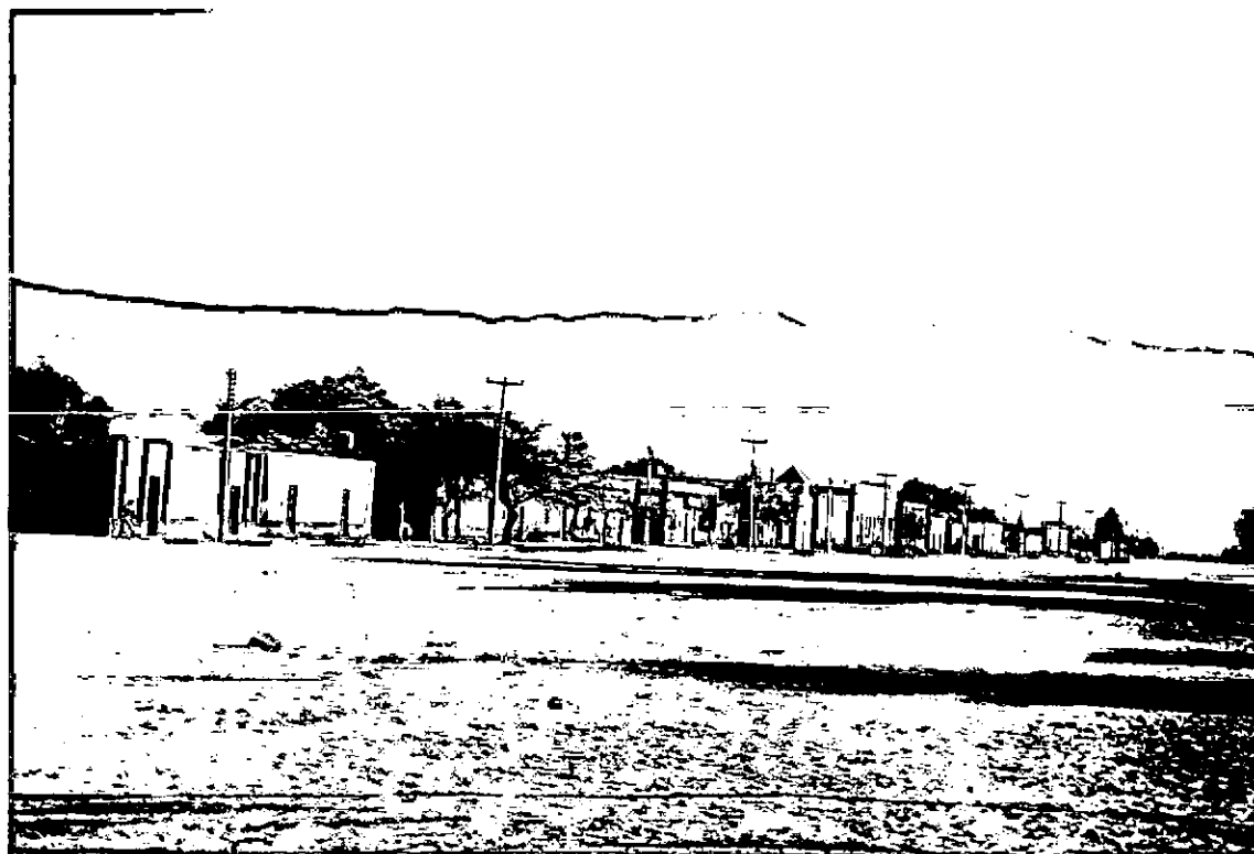
FOTO N° 3: Vista de la calle principal de la localidad, Dr. Carlos Brizuela del Moral, de aproximadamente 48 m de ancho. Puede verse el tendido de las líneas eléctricas y de alumbrado público con postes de hormigón y ménsulas con luminarias metálicas. Los postes se hallan a una distancia de unos 60 metros entre sí.
