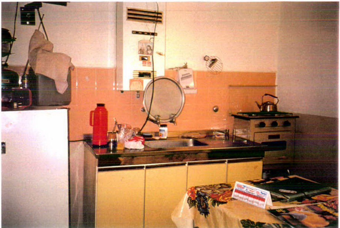
FOTO N° 46: Cocina del Hospital en la que se ha instalado un calefón a gas (que no funciona), una cocina a gas conectada a una garrafa. Hay además una heladera en mal estado, un televisor y un ventilador de techo. Tanto el televisor como la cocina han sido comprados por el personal.
