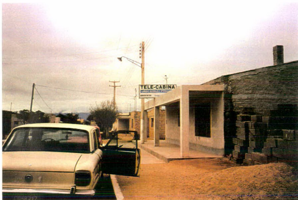
FOTO N° 18: Telecabina de TELECOM que aun no ha sido habilitada, que contaría con servicio de Fax y que permitiría además realizar llamadas internacionales. Está situada a la entrada de la localidad.
