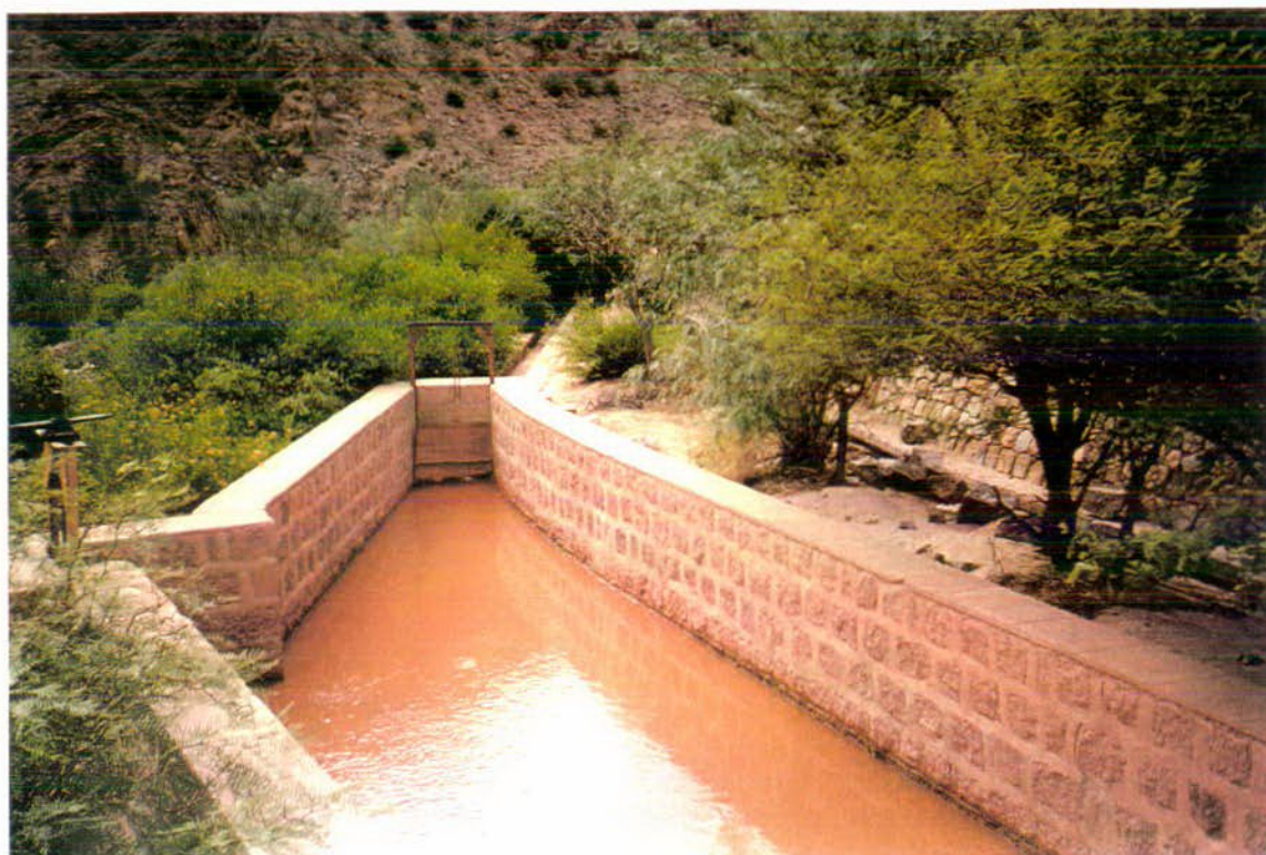
FOTO N° 28: Vista del desripiador ubicado a continuación del azud en el río Salado. Permite decantar el material más grueso que arrastra el río.
