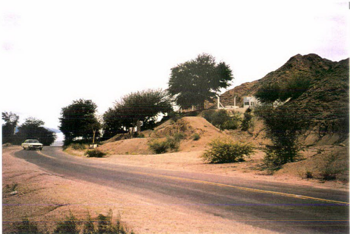
FOTO N° 27: Vista de la Planta Potabilizadora de Villa Mazán, ubicada sobre la R.N.N° 60 a la entrada de la localidad.
