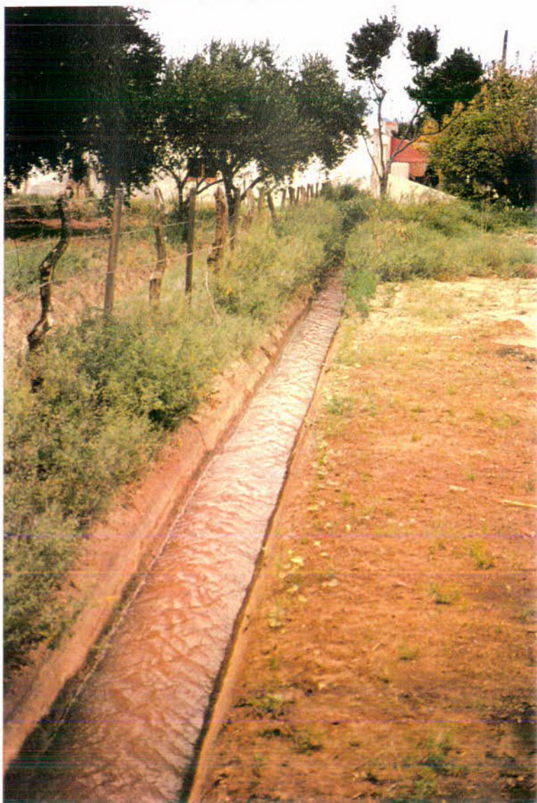
FOTO N° 32: Vista del Canal Matriz y de un partidor con compuertas que permite distribuir el agua para riego a los canales primarios que a su vez la conducen a las propiedades por canales secundarios y acequias.
