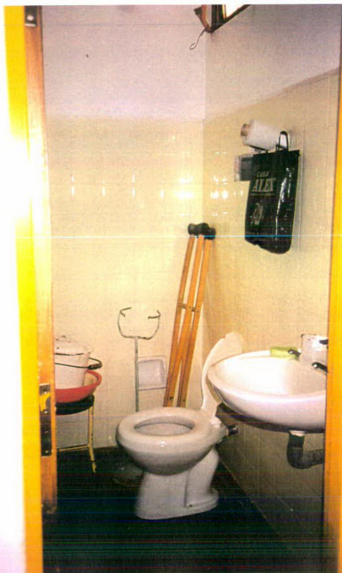
FOTO N° 49: Vista de uno de los baños del Hospital: se encuentra en buenas condiciones. tiene pileta e inodoro y está azulejado. El edificio tiene pozo ciego y cámara séptica.
