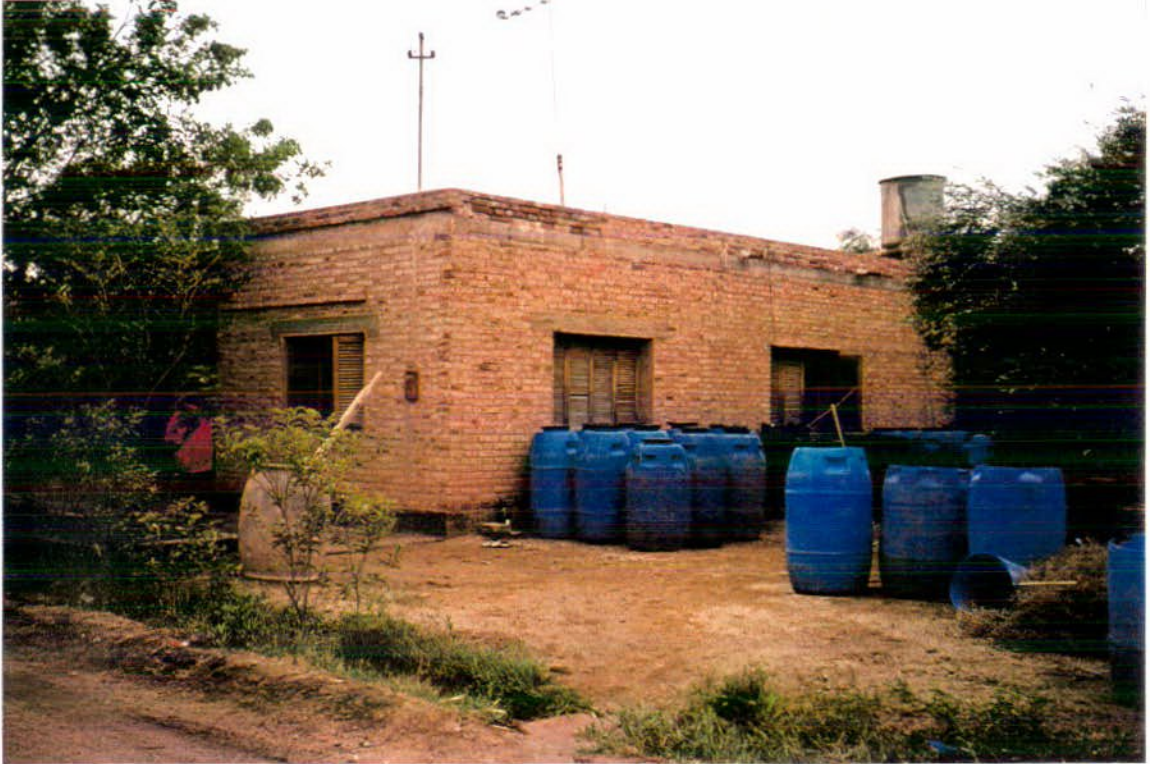
FOTO N° 13: Vista de las casas de ladrillo características de la localidad.
