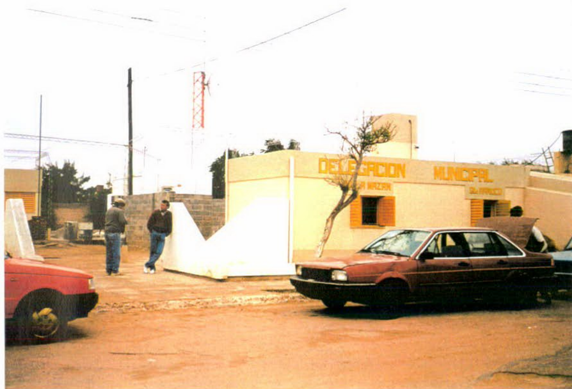
FOTO N° 16: Vista en segundo plano de la central de TELECOM con que funciona el sistema telefónico en la localidad. Está ubicada en el Barrio San Isidro, junto a la estafeta postal, el Hospital Seccional y la Delegación Municipal.
