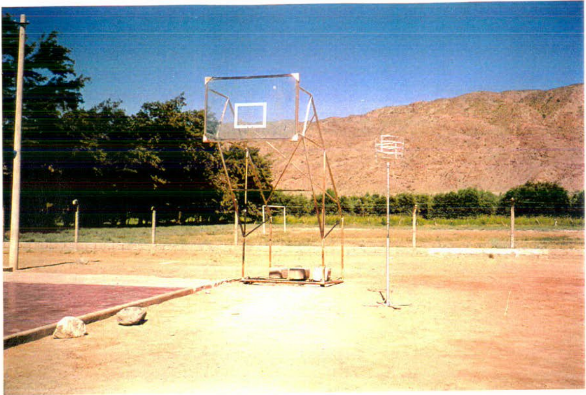
FOTO N° 54: Parte posterior del edificio escolar donde hay un patio con una cancha embalsada para hacer deportes, y atrás de ella, un terreno sin su correspondiente cerramiento donde se practica fútbol.
