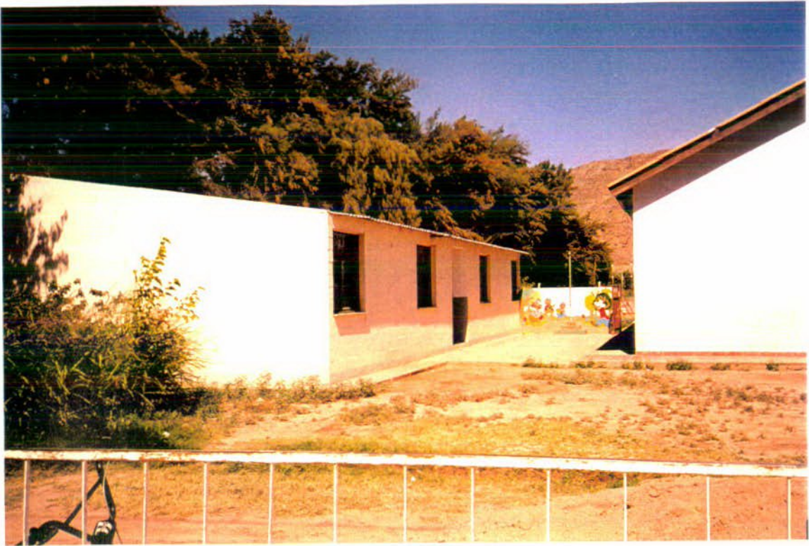
FOTO N° 60: Edificio del Jardín de Infantes que está ubicado a un costado del de primaria y fue concretado con fondos del Plan Social Educativo. Está construido con bloques y tiene techos de chapa con pendiente.
