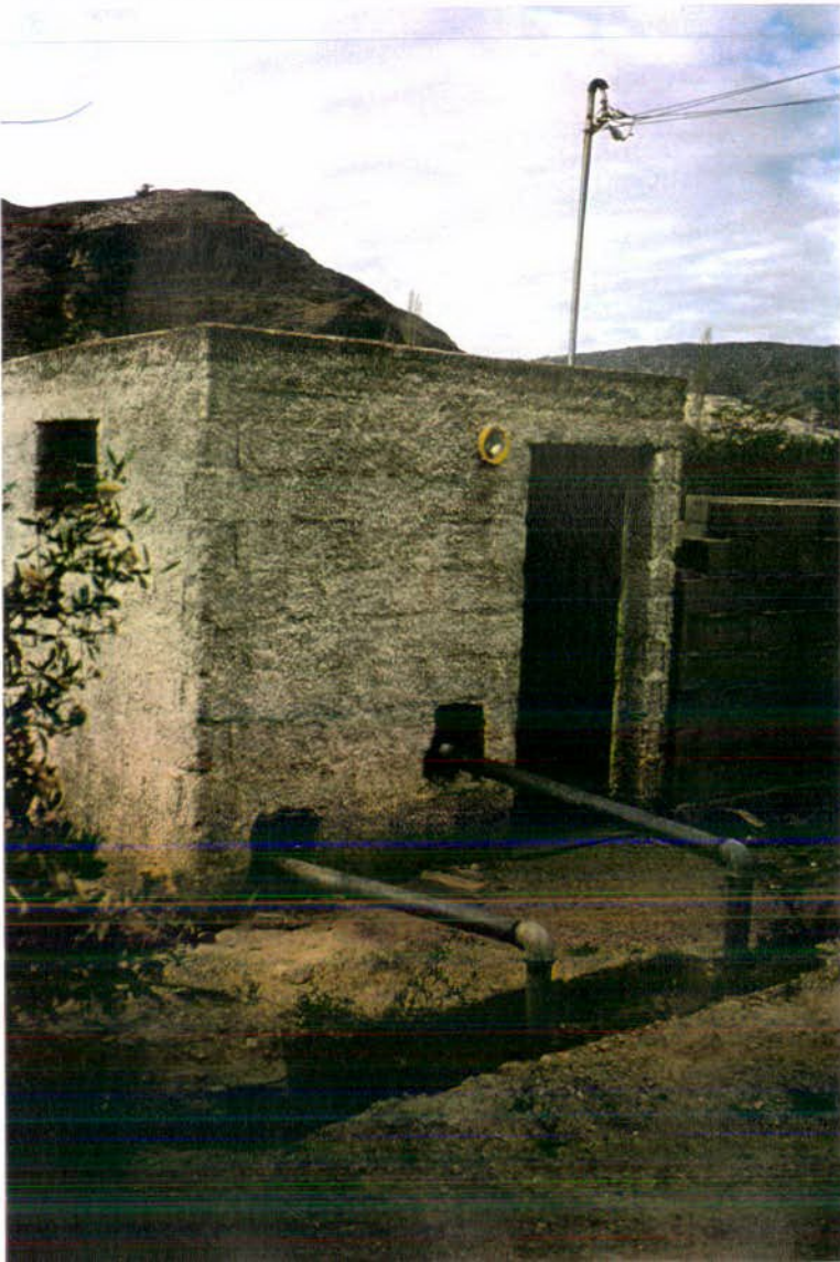
FOTO N° 25: Vista del acueducto a presión con agua procedente de Las Chilcas que se deriva a la altura del azud en el río y que la transporta hasta la estación de bombeo desde donde se la eleva a la planta potabilizadora de la localidad.
