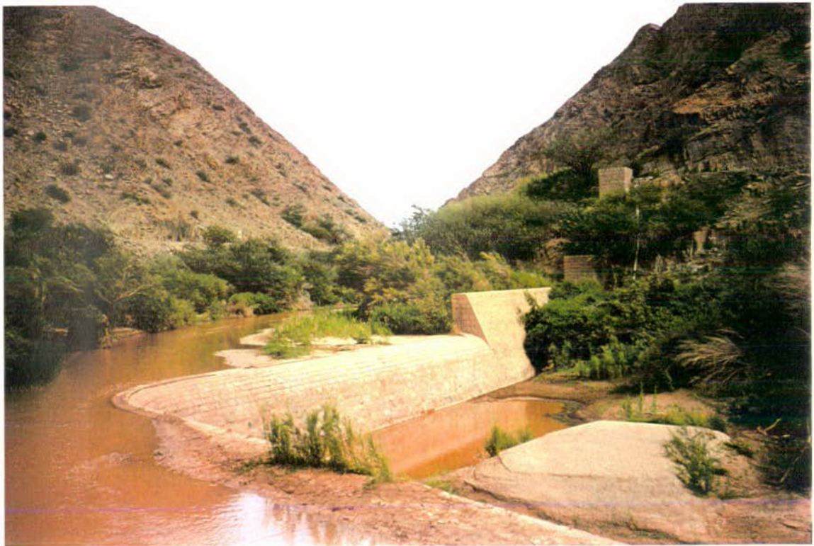
FOTO N° 24: Azud derivador que capta el agua del río Salado para ser utilizada para riego junto con la que llega desde Las Chilcas y que no se deriva a la planta potabilizadora para consumo humano.
