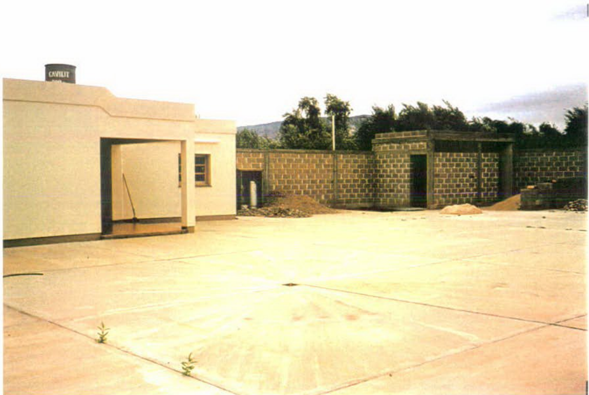
FOTO N° 83: La casa donde funciona la Unión Vecinal, consta de una sala principal, un baño, una cocina, una galería abierta, un pabellón sanitario que a la fecha del relevamiento encontraba en construcción y un amplio patio con portón metálico.
