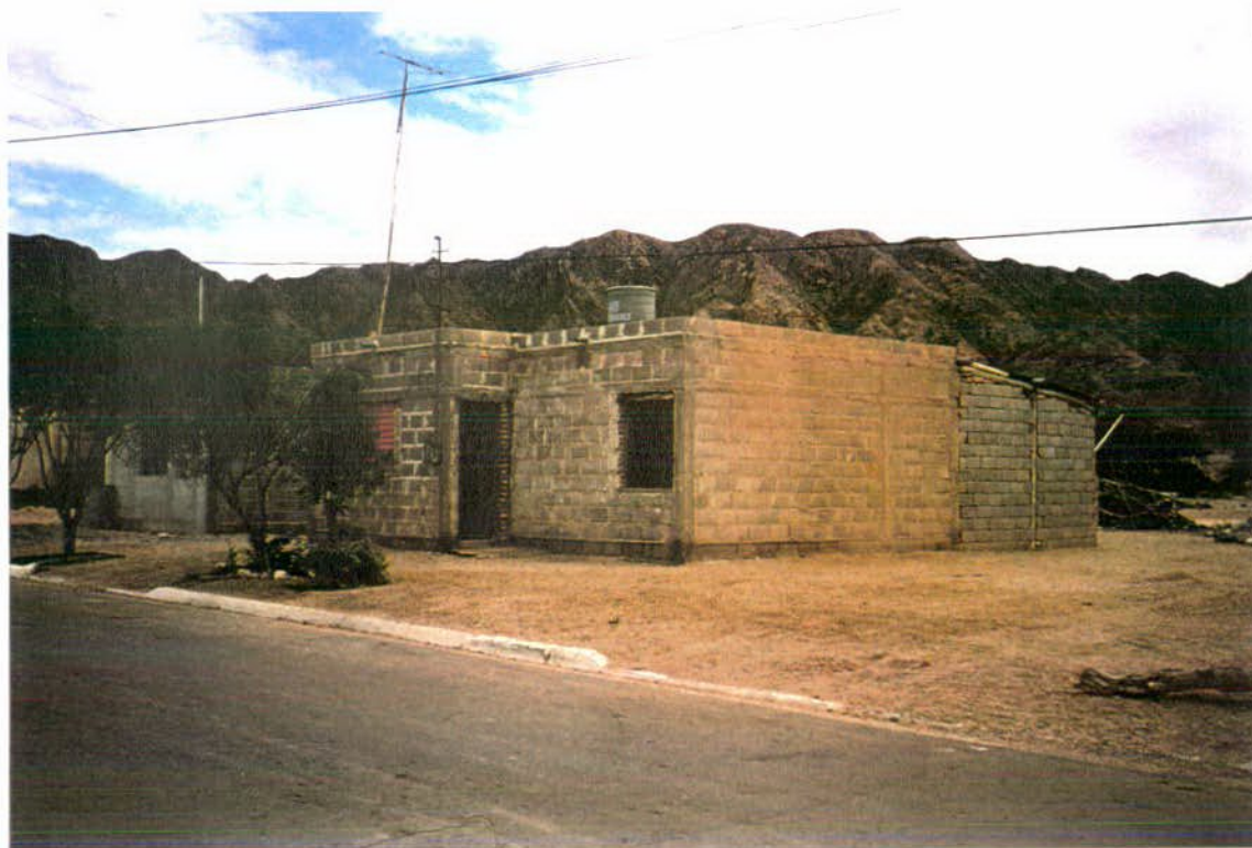
FOTO N° 12: Vivienda típica de la localidad construida en bloques de cemento y sin revoque. Tiene luz, agua y tanque elevado de fibrocemento. La mayoría tiene baño instalado con pozo ciego y cámara séptica.
