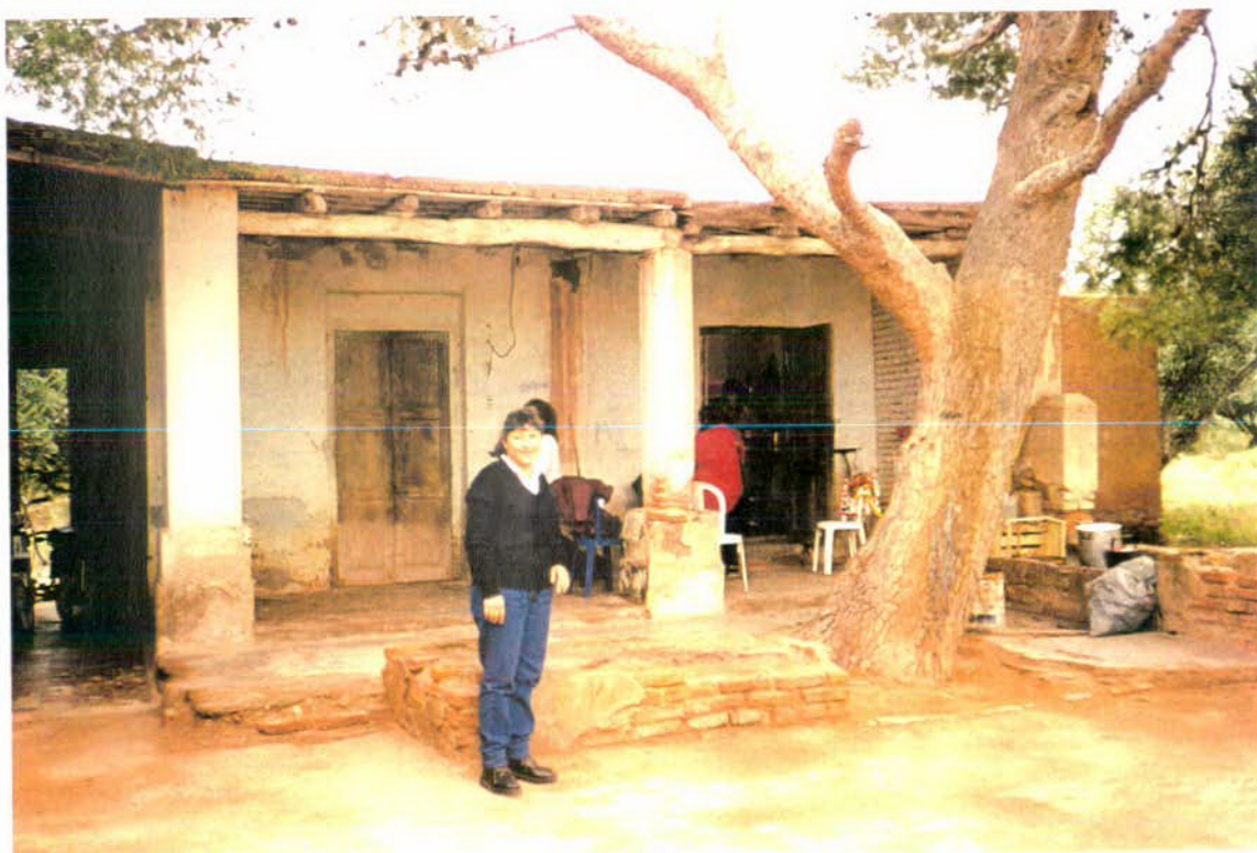
FOTO N° 67: “La Casona” es una construcción de adobe, con techos de caña, barro o ladrillos y rollizos de madera; las puertas y ventanas son de madera y los pisos son de baldosas y de alisado de cemento.
