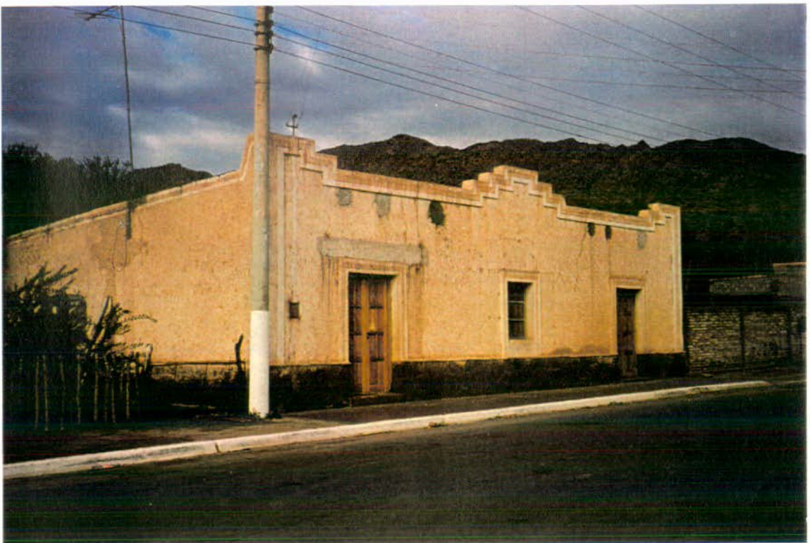
FOTO N° 14: Vista de una de las viviendas tipo de adobe revocado que se encuentran en la localidad.
