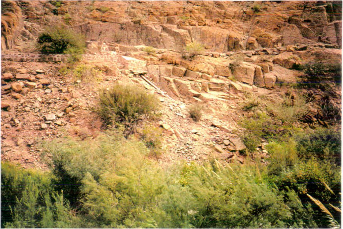
FOTO N° 25: Vista del acueducto a presión con agua procedente de Las Chilcas que se deriva a la altura del azud en el río y que la transporta hasta la estación de bombeo desde donde se la eleva a la planta potabilizadora de la localidad.
