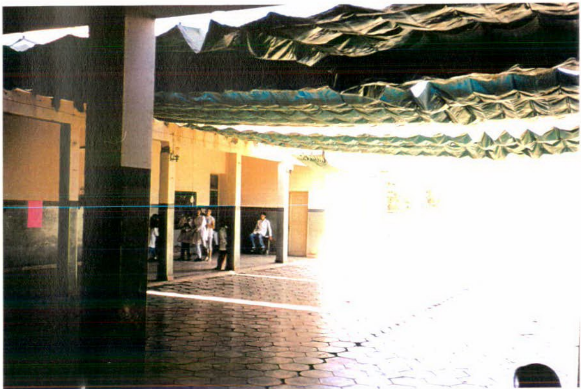
FOTO N° 53: Vista de las galerías internas cubiertas dispuestas alrededor del patio central del edificio escolar. Los pisos de las mismas son de granito. El patio central está revestido con baldosas de alisado de cemento de forma hexagonal y tiene toldos plásticos que lo cubren en su totalidad.
