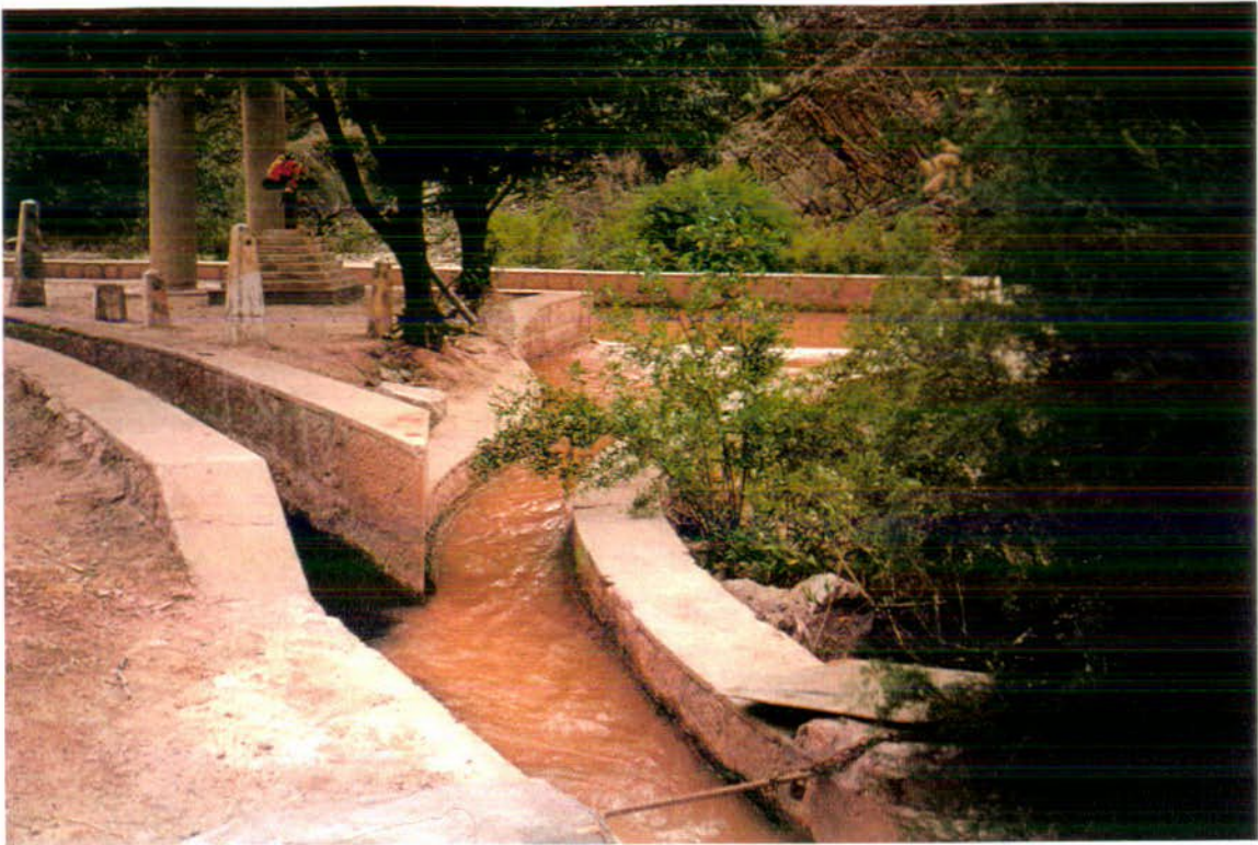
FOTO N° 30: Lugar en que se junta el agua del río luego de pasar por el desarenador y el desripiador con la remanente del acueducto de Las Chilcas y que no ha sido utilizada para abastecimiento humano. Aquí es donde se origina el Canal Matriz de Riego.
