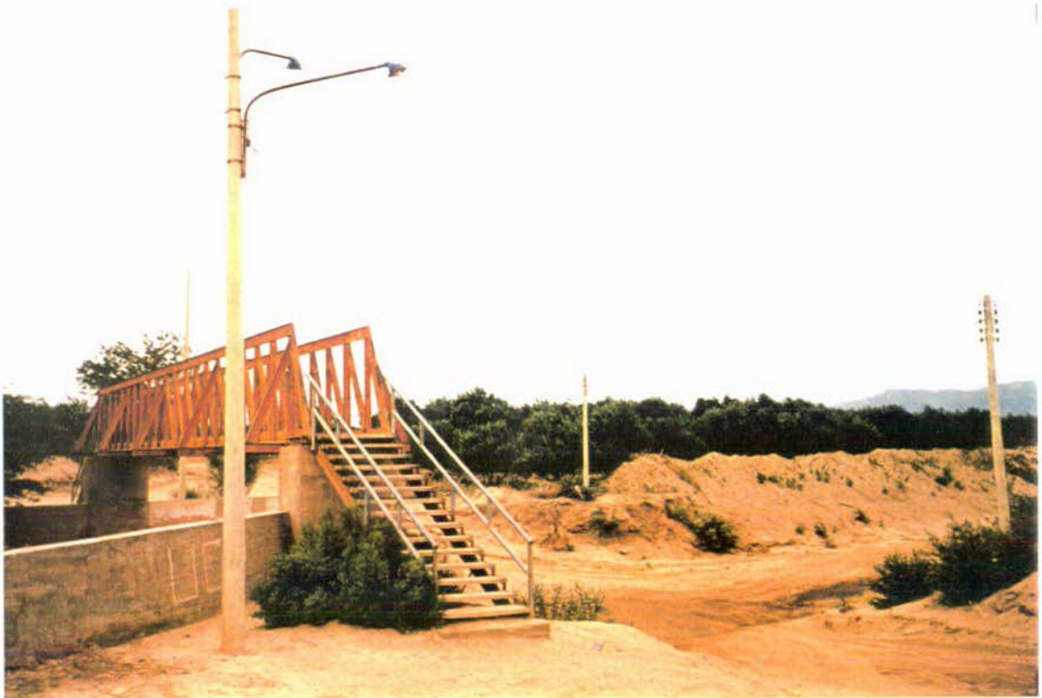
FOTO N° 85: Vista del cruce peatonal sobre el río Salado que permite comunicar los Barrios Las Flores y El Médano.
