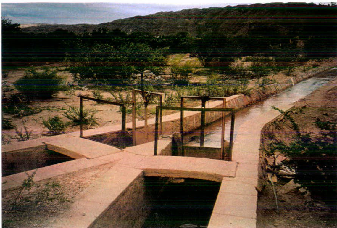
FOTO N° 32: Vista del Canal Matriz y de un partidor con compuertas que permite distribuir el agua para riego a los canales primarios que a su vez la conducen a las propiedades por canales secundarios y acequias.
