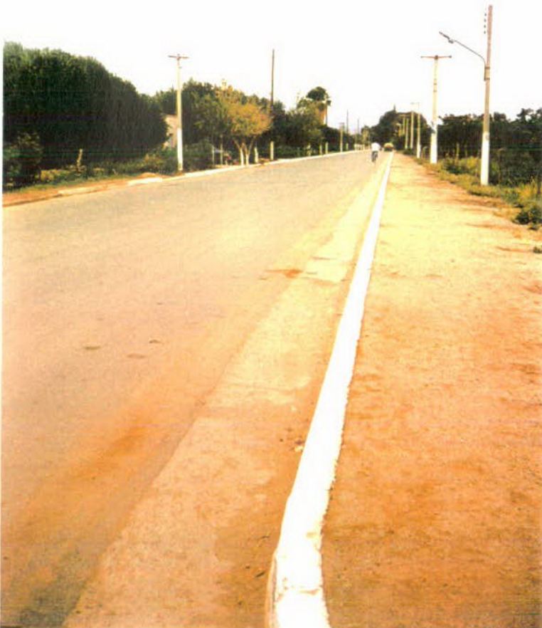
FOTO N° 7: Ruta Provincial N° 10, que toma el nombre de Av. César Vallejos en el centro de la localidad, y que constituye el eje del pueblo en dirección norte - sur.
