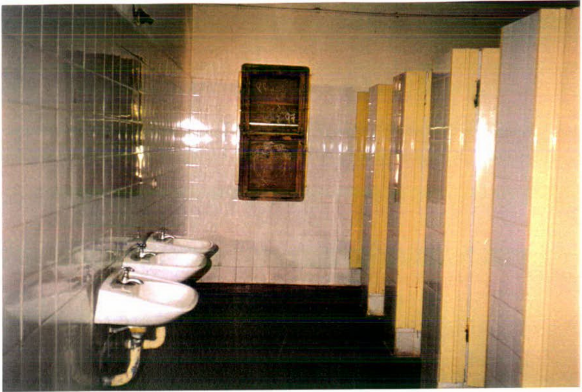
FOTO N° 56: Baño de las niñas que tiene tres lavatorios y cinco inodoros instalados. Está revestido con azulejos comunes y tiene pisos de baldosas calcáreas.
