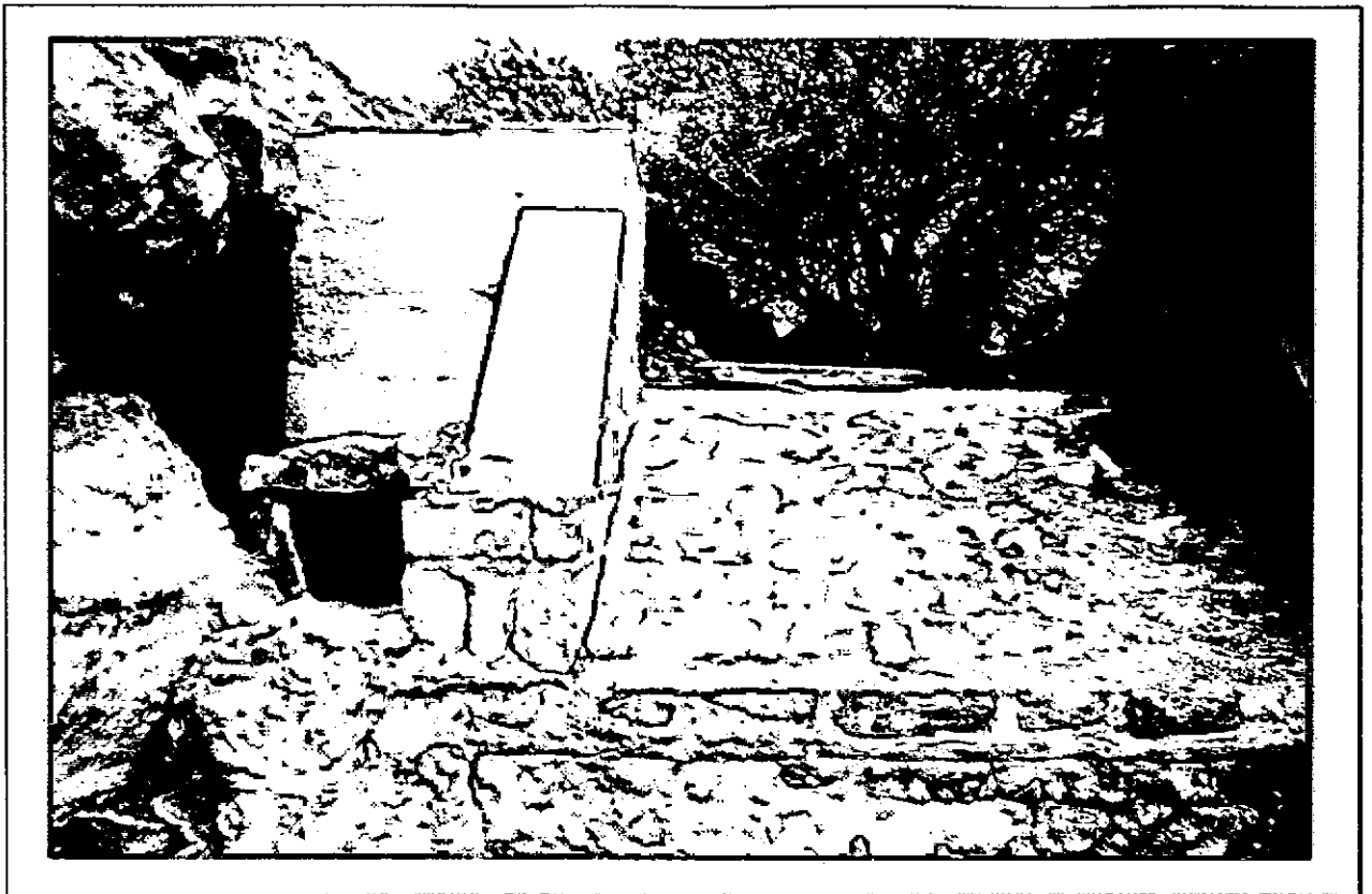
Fotografía 15: Cámara y vertedero de protección en acueducto principal.
