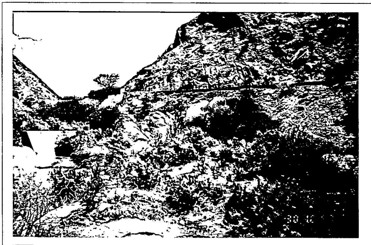
Fotografía 12: Vista de acueducto empircado (caño asbesto cemento) que alimenta a la planta potabilizadora.
