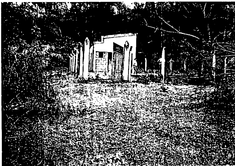
VILLAMONTE: Depósito de almacenamiento de agua y casilla de cloración.
