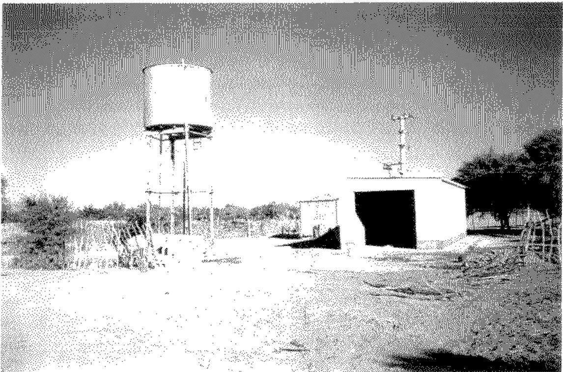
**FOTO N° 7:** Pozo de agua y tanque elevado ubicado en el barrio Los Cabrera, construídos en principio para el abastecimiento a toda la localidad. En la foto puede verse la construcción dentro de la cual se ha instalado una planta potabilizadora de ósmosis inversa que posibilitará, una vez puesta en funcionamiento, mejorar la calidad del agua para consumo de la población. Asimismo, muestra las excavaciones realizadas para la instalación de dos cisternas que permitirán almacenar el agua
