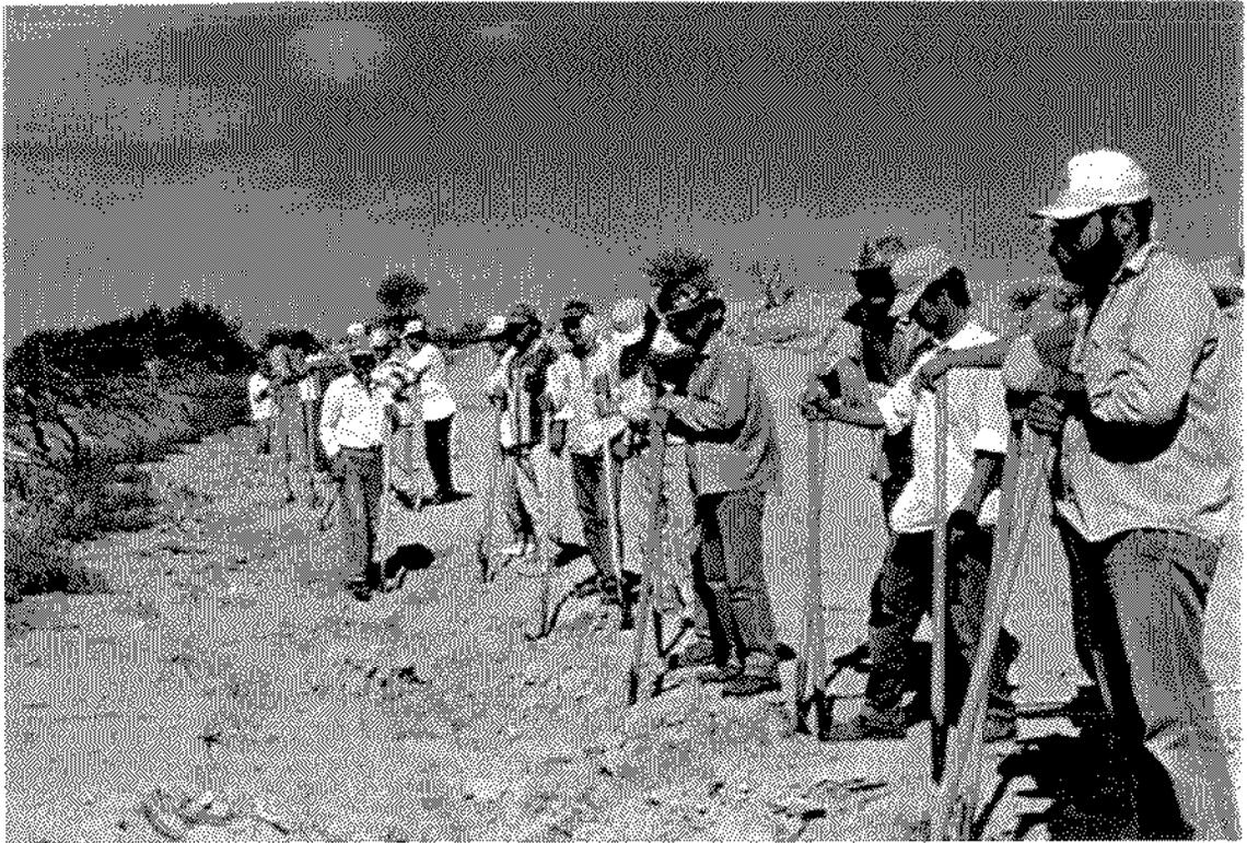
**FOTO N° 22:** Construcción de la "toma" que todos los años realizan los pobladores de la localidad para desviar el agua del río Salado hasta sus campos cultivados (rastros), para ser utilizada en el riego de los mismos.
