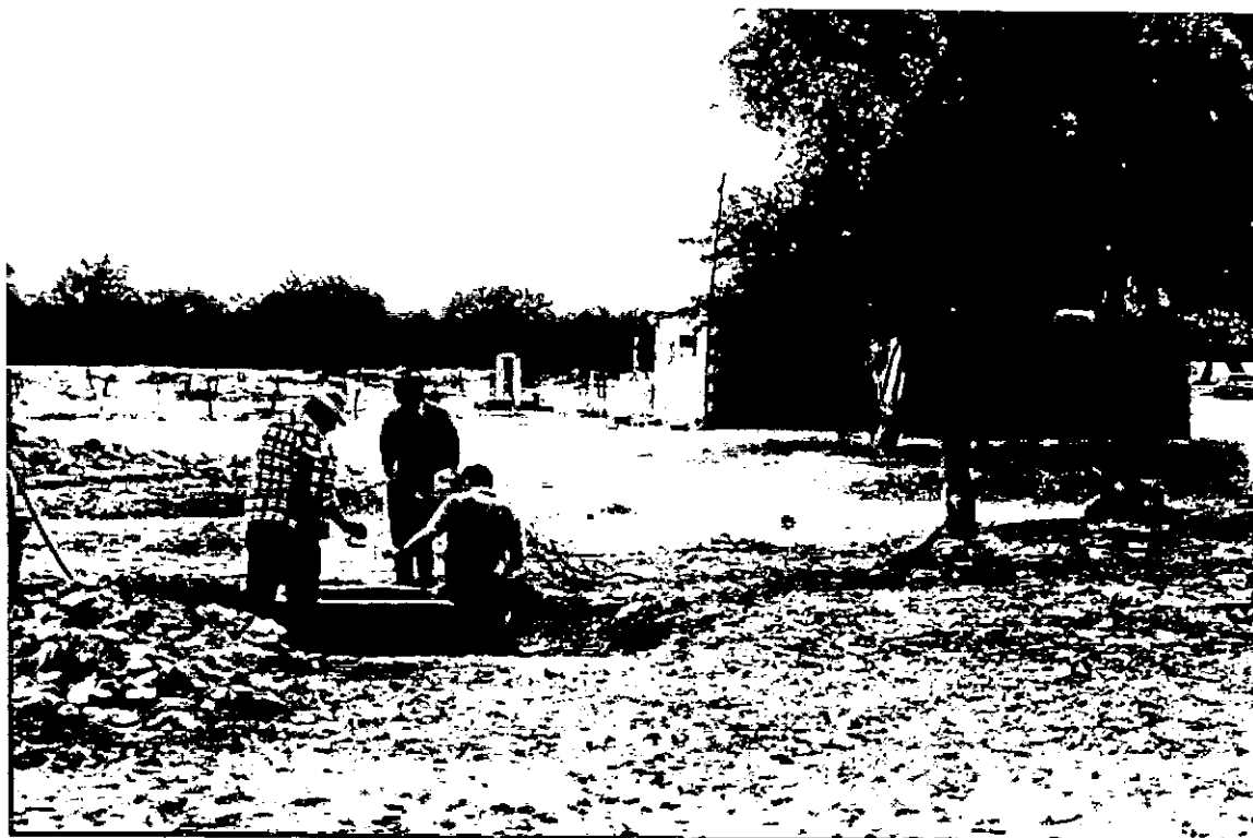
FOTO N° 2: Pozo cavado de poca profundidad y baja producción, de uso comunitario. Atrás casa Tipo B de bloques.
