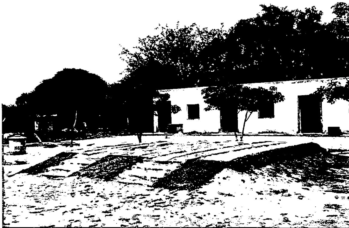
FOTO N° 5: Vista de la vivienda de los maestros en la escuela que se proyecta aprovechando su techo para el almacenamiento de agua de lluvia en aljibe que se propone construir.
