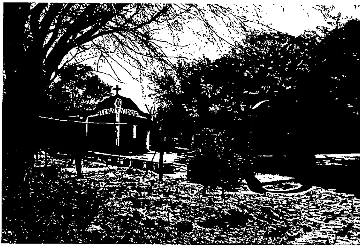
FOTO N° 2: Vista de la capilla que se encuentra en buen estado. Se prevé la llegada con grifo público hasta éste sector.
