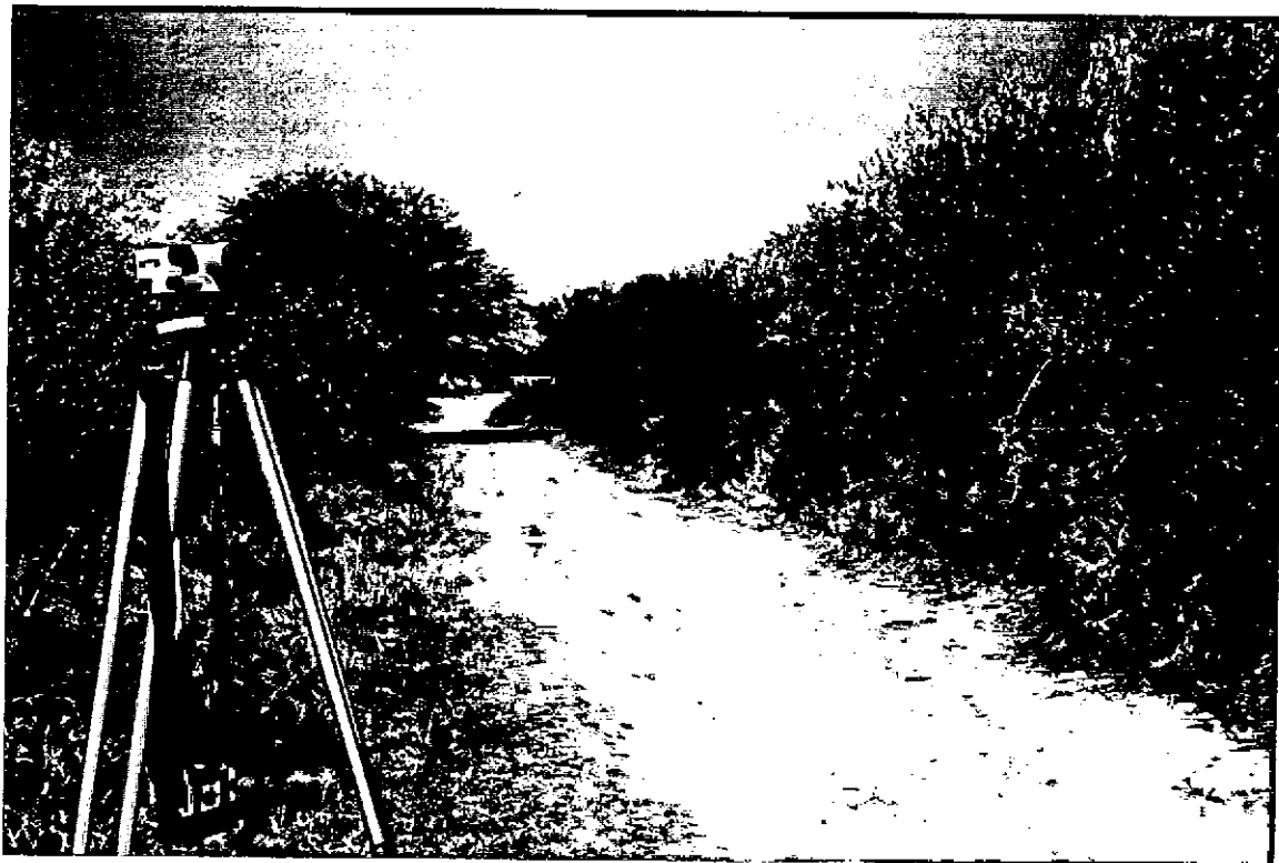
FOTO N° 6: Picadas características de la zona por donde se prevé la distribución de la cañería.
