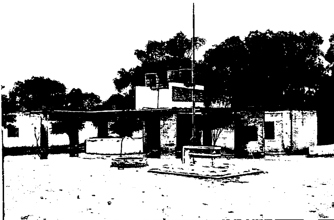
FOTO N° 4: Escuela N° 1034. Se observa la galería que se proyecta completar y conectar al aljibe existente. Se proyecta además la refacción de techos, revoques y pintura.
