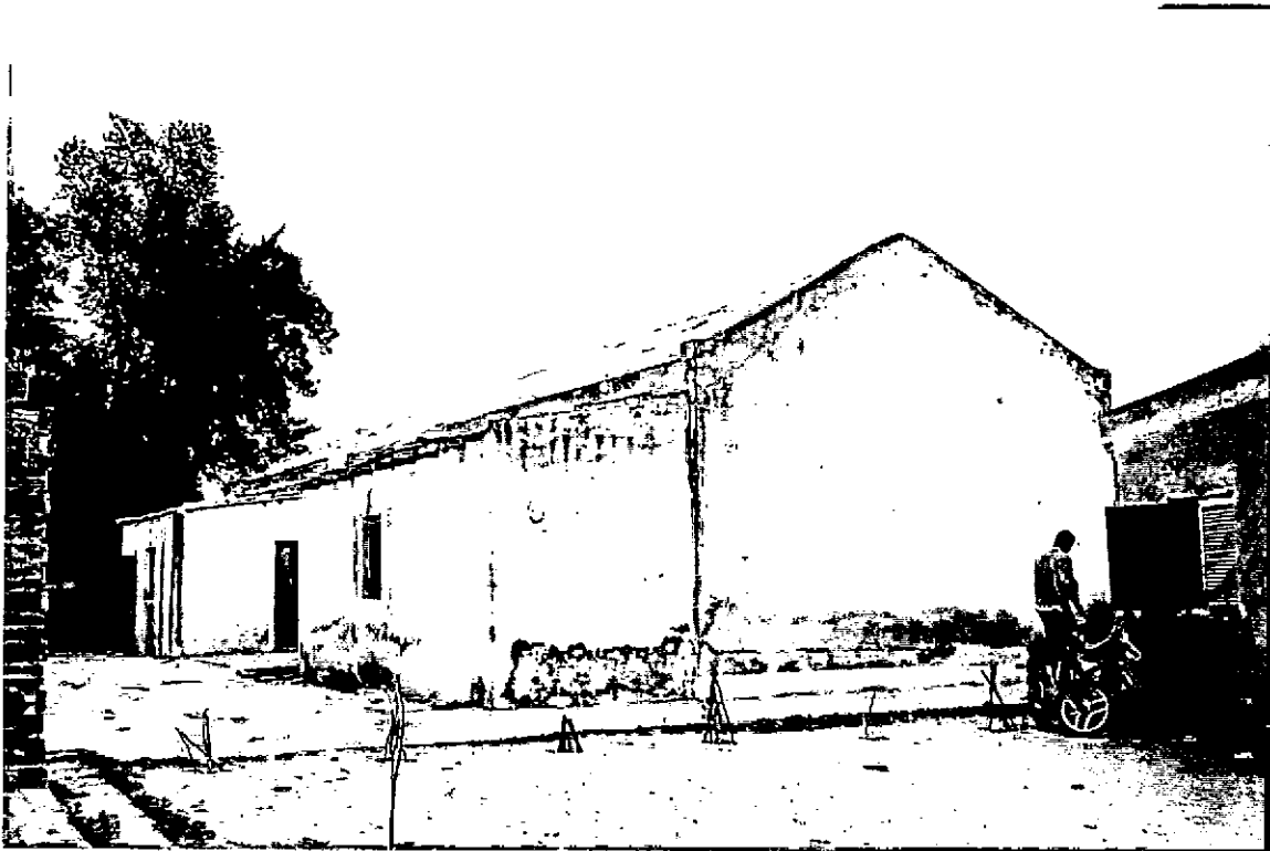
FOTO N° 5: Sector de la escuela donde se observa la deficiencia en techos, revoques y pintura.
