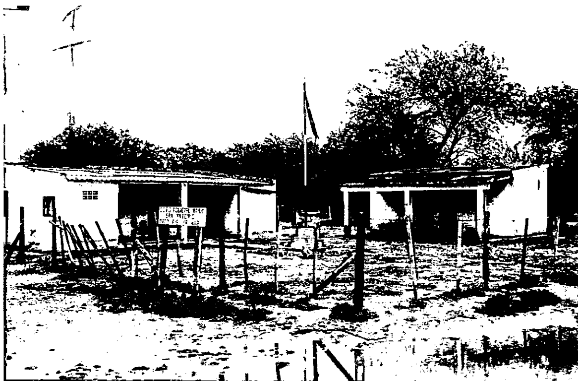
FOTO N° 6: Puesto Policial. Se propone además de las adecuaciones de pinturas y aberturas, la conexión de los techos a un aljibe a construir entre ambos edificios.
