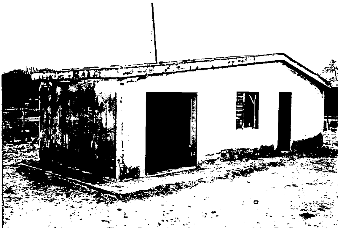
FOTO N° 6: Vista del Puesto Sanitario, se observa el mal estado de aberturas, del techo y falta de pintura.
