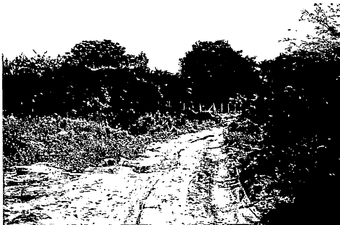
FOTO N° 8: Vista del estado de los caminos donde se proyecta la traza de la cañería de distribución, observando el estado de carcavamiento debido a lo inestable del suelo.
