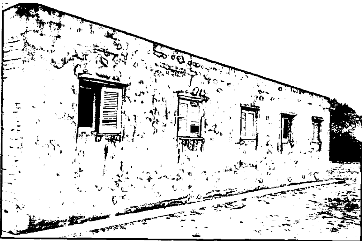
FOTO N° 6: Se observa el mal estado de aberturas y falta de pintura en la escuela.
