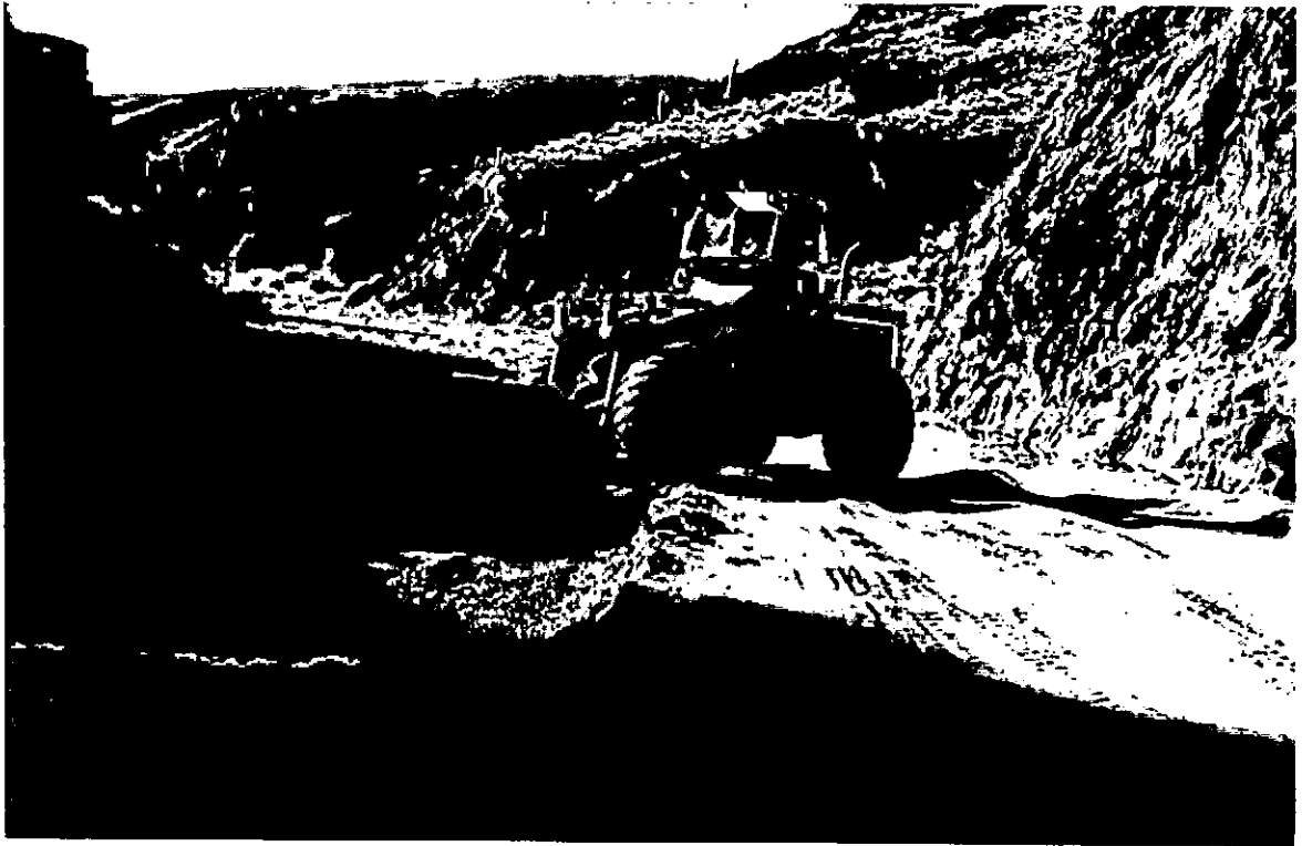
foto 1- La máquina realizando el descarpe de material estéril.
