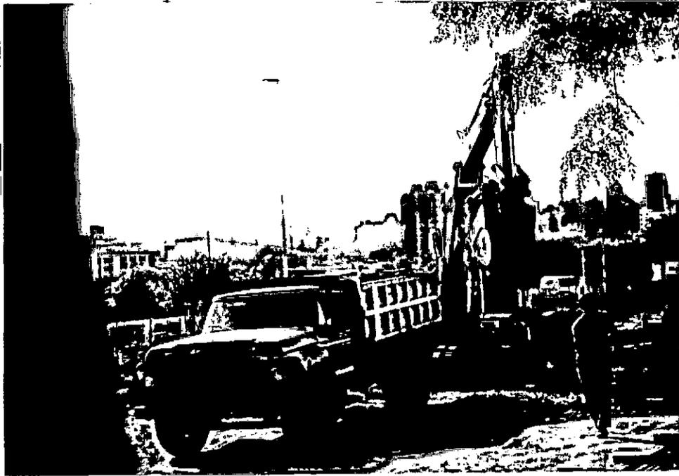
Obreros transportando hierros pasan por debajo del radio de acción de la cuchara de la excavadora.
