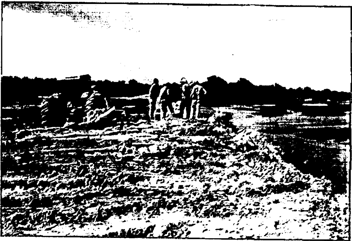
Foto Nro. 20: Borde superior de la defensa a poco de ser construida.
