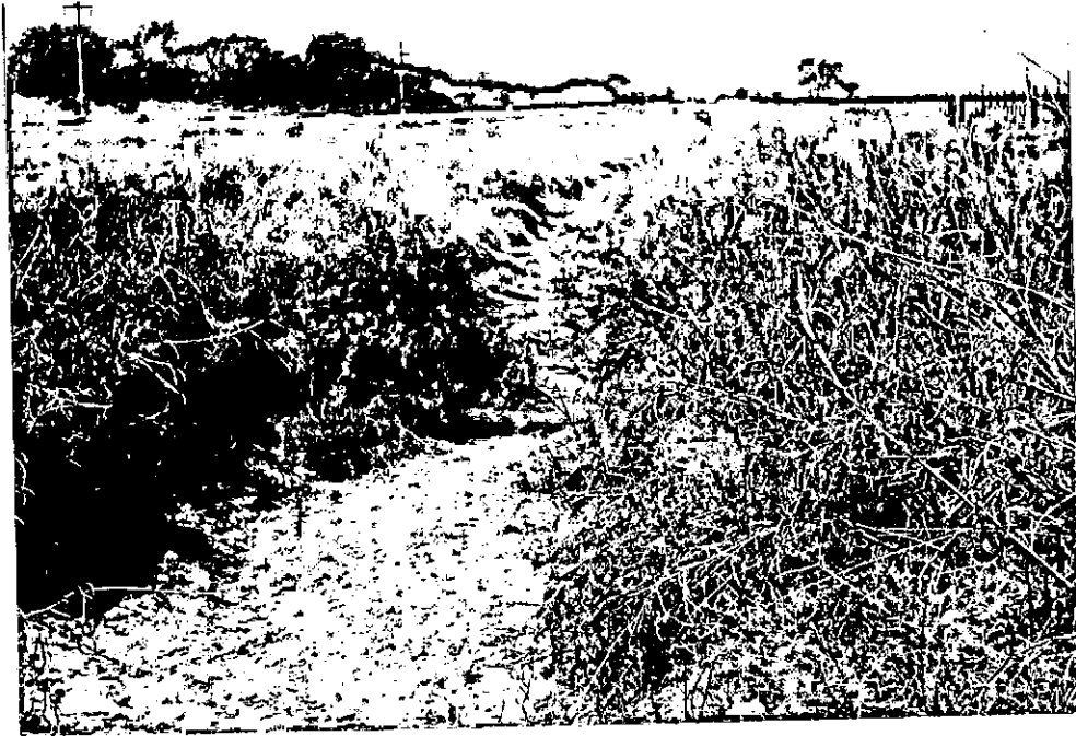
erosión en caminos
