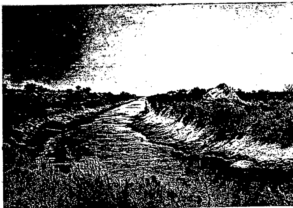
Nº 10 - Canal Nº 4 (Prov. Santa Fe) aguas abajo del puente ruta Nº 2. Obsérvese la gran pendiente que tiene. El ancho es de aproximadamente 25 m y 4 m de alto.
