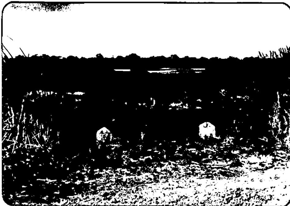
Alcantarilla ubicada 3 Km al norte de la Ruta Prov. Nº 17, con buen escurrimiento, tomada hacia el S.E. El Caudal aforado fue de  $0.67 \text{ m}^3/\text{s}$
