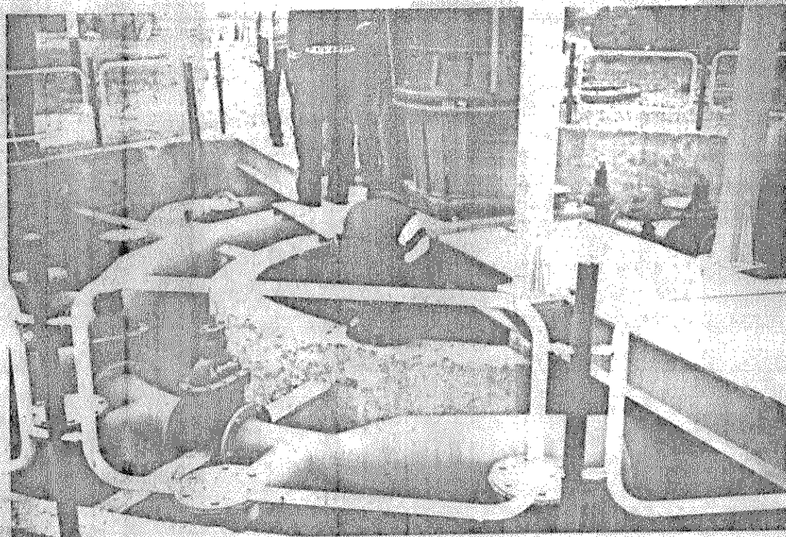
Foto N°10: Dispositivo de pozos de recarga (centro) y limpieza (anillo) en el Rfo Besos (Sociedad General de Aguas de Barcelona).
