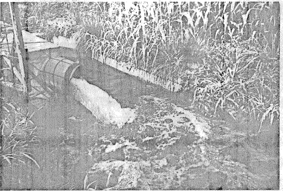
Foto N°6: Caudal proveniente de un pozo entregado a un canal de conducción (Barcelona).
