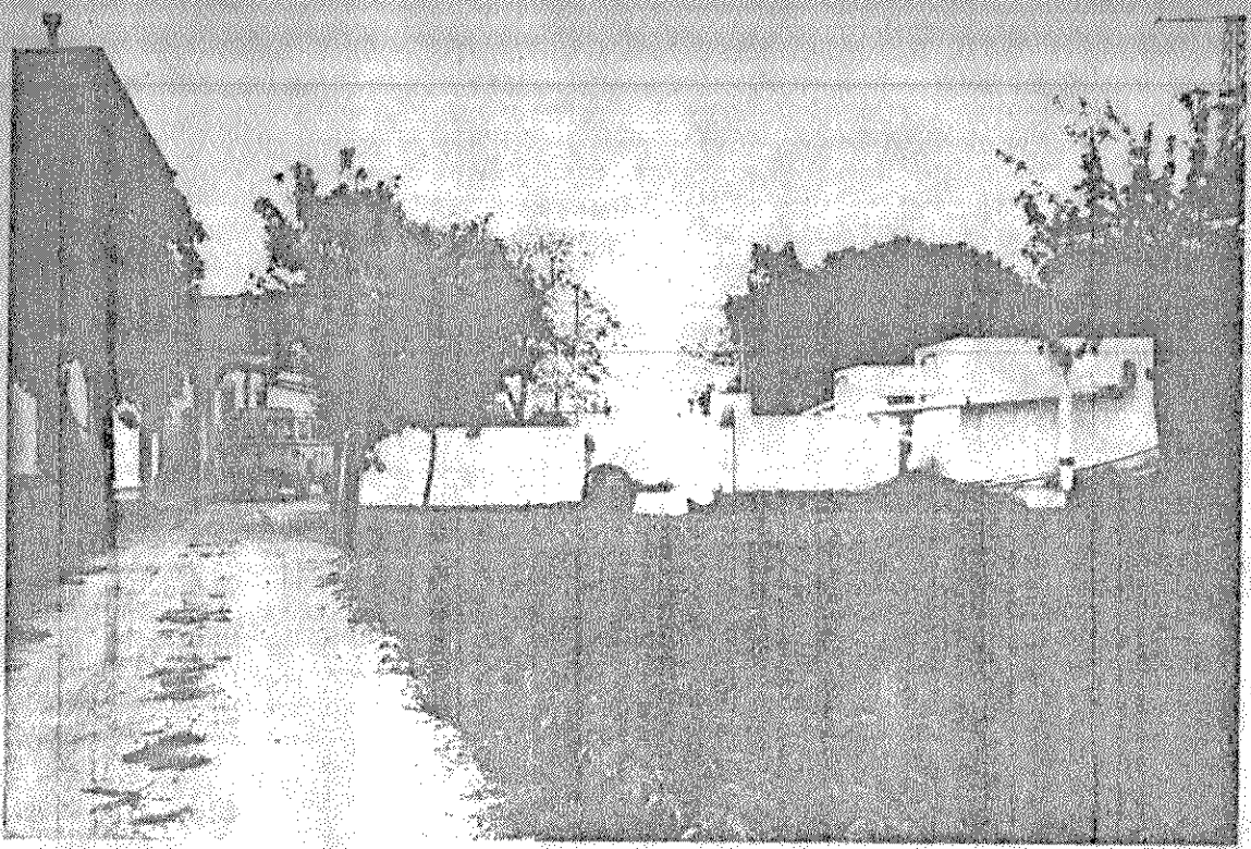
Foto N°5: Planta potabilizadora de Playa de Aro-Provincia de Gerona.
