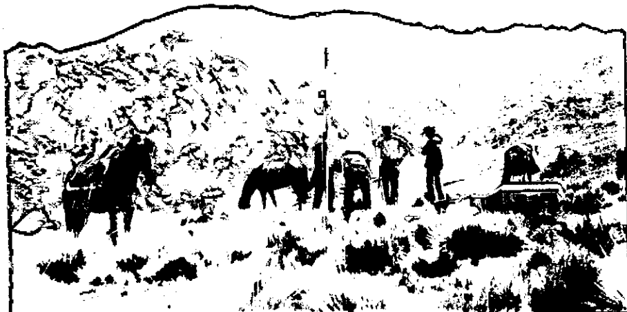
FOTO Nº 8. COMIENZO DEL ARMADO DE LA TORRE Nº2, AL FONDO EL CO. MOGOTE DE LA CRUZ.
