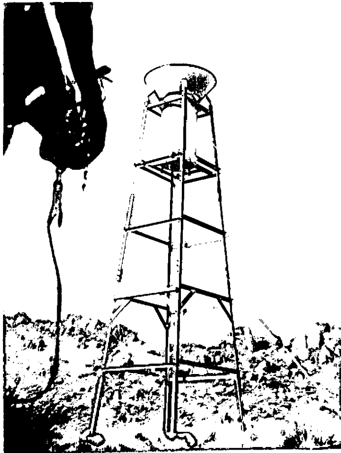
FOTO Nº 12. OTRA VISTA DE LA TORRE DEL TOTALIZADOR Nº2.
